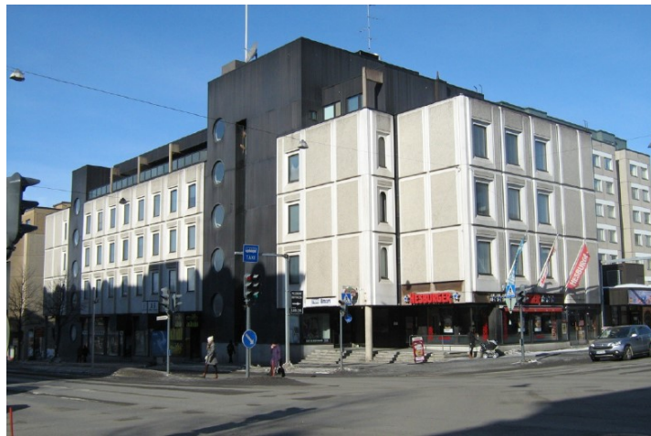
Kuva 3. Suunnittelualueella oleva vuonna 1976 rakennettu, arkkitehti Kosti Kurosen suunnittelema, alun perin Suomen työväen Säästöpankiksi suunniteltu rakennus. Rakennus on toiminut vuodesta 1997 lähtien opiskelija-asuntolina. Kuva: Neva Arkkitehdit 2019.
