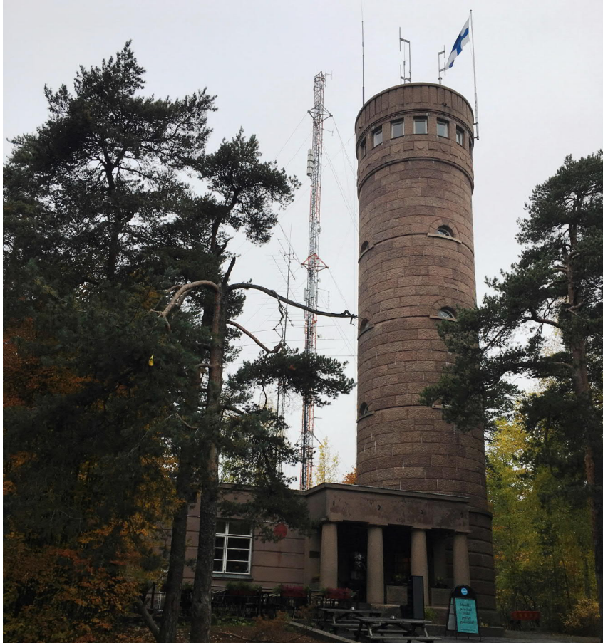
Kuva 5-2. Pispalan näkötorni sijaitsee pohjavesialuerajausmuutoksen jälkeen Epilänharju-Villilä A pohjavesialueella. Tornissa on myös Tampereen Sähköverkko Oy:n muuntamo.
