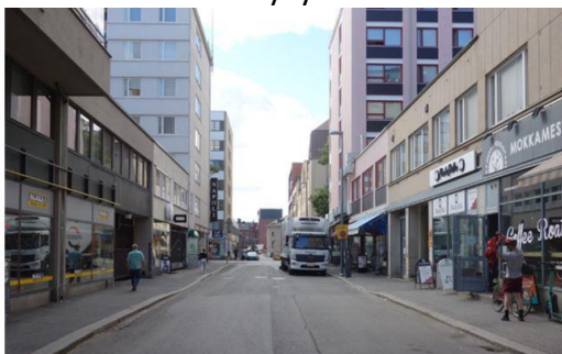
Jalkakäytävä 2 m Reunakivi 8-10 cm Asfaloitu ajorata ja pysäköinti 7,5 m Jalkakäytävä 2 m
