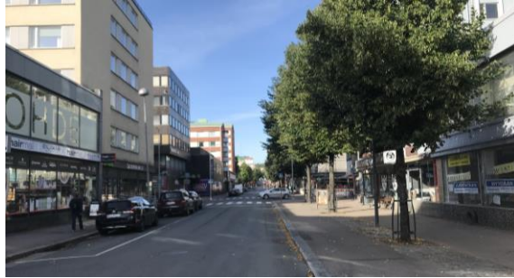
Asfaltoitu jalkakäytävä 3 m Pysäköinti jalkakäytävä 2 m Ajourata 6 m Reunakivi 8-10 cm Pyörätie 2,5 m Katupuut 2 m Asfaltoitu jalkakäytävä 2,5 m
