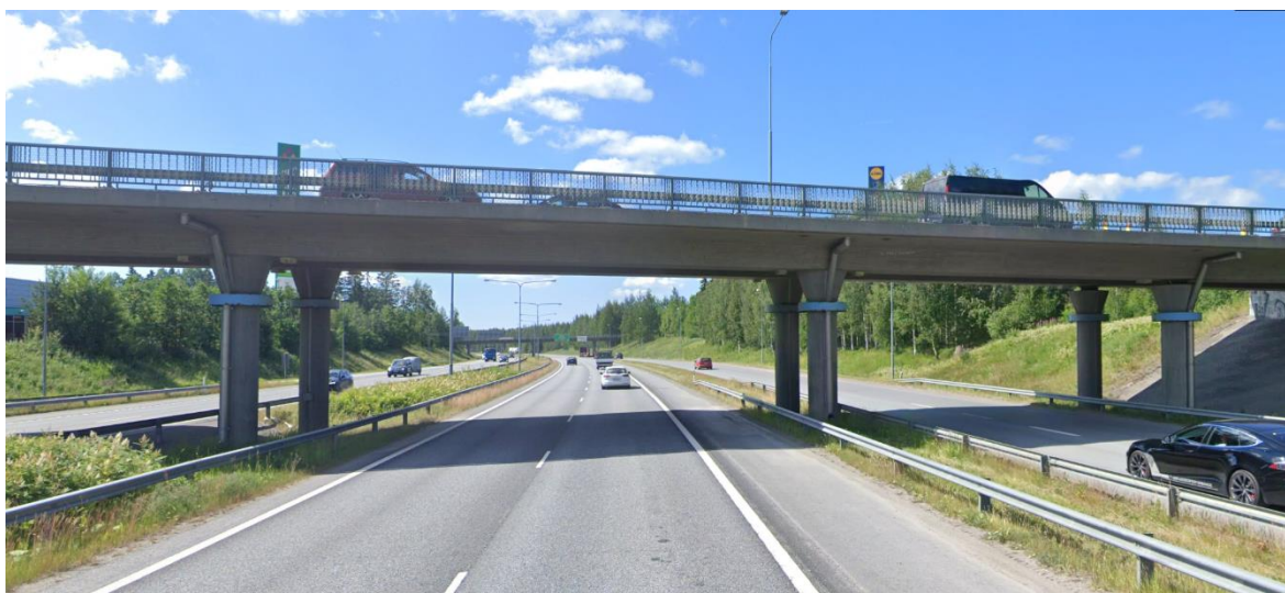
Kuva 3. Heikkilänkadun nykyisen sillan kuivatus ja syöksytorvet (Google Street View 2023)
