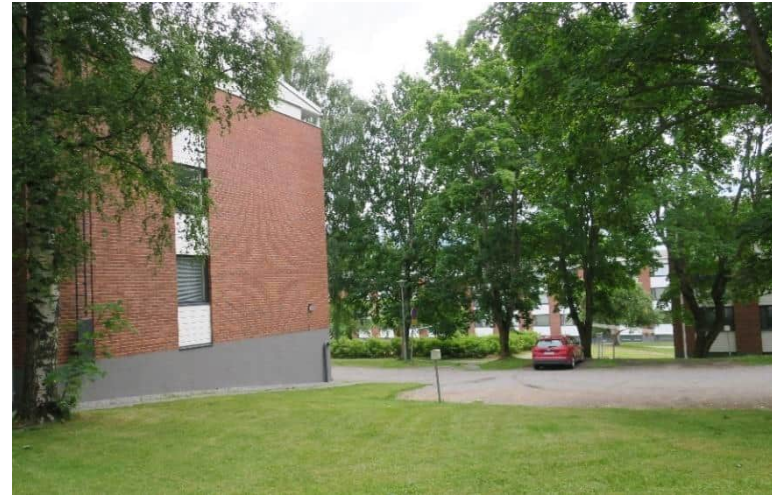
Kuva 52. Lamellitalojen väliin jää pysäköintialue.
