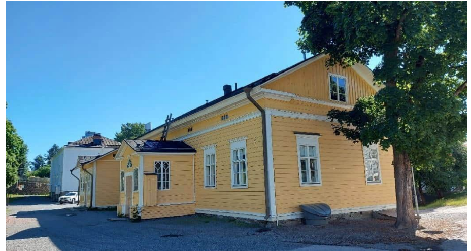
Kuva 72. Koulun vanha rakennus, itäpääty Wivi Lönnin suunnittelema laajennus, takana oleva kuisti on entisen kappelikirkon kuisti.
