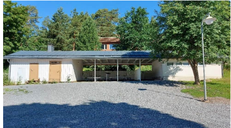
Kuva 77. Koulun pihapiirin huoltorakennus.
