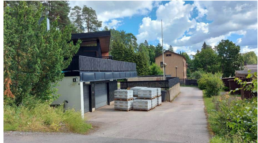
Kuva 60. 1960-luvun rakennus. Taustalla 1920-luvun pientalo.
