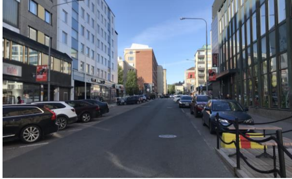
Asfaloitu jalkakäytävä 2,8 m Viistopysäköinti 4 m Asfaloitu ajorata 6 m Pysäköinti 2 m Reunakivi 8-10 cm Asfaloitu jalkakäytävä 2,8 m
