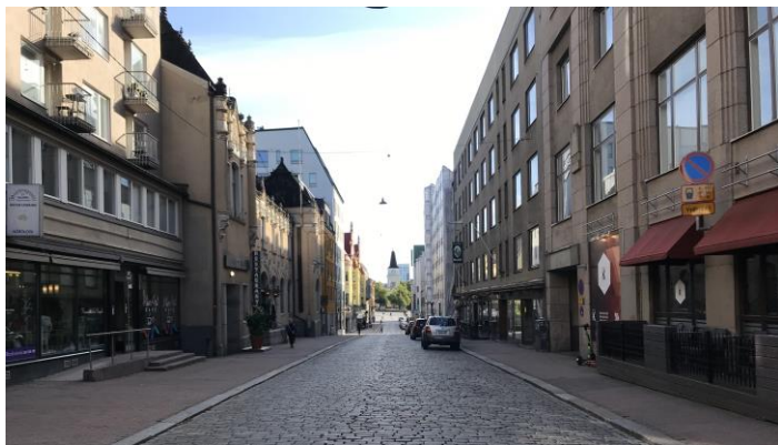
Jalkakäytävä 2-3 m Reunakivi 8-10 cm Nupukivinen ajorata ja pysäköinti kadun reunassa 7 m Reunakivi 8-10 cm Jalkakäytävä 2-3 m
