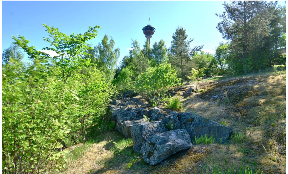
Kuva 11: Särkänniemen kivirakenne muodostuu suurikokoisista lohkoista kivistä. Kuva Pirkanmaan maakuntamuseo, 2018.
