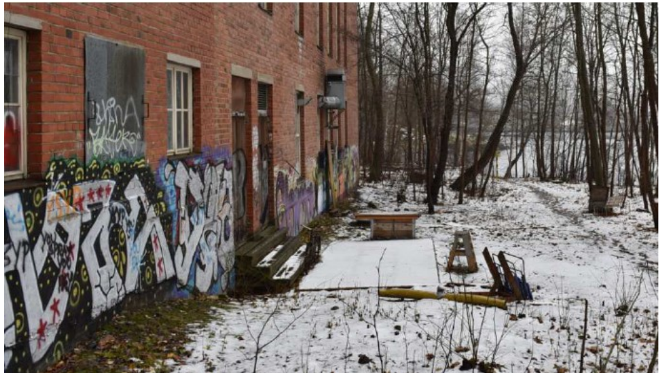
Kuva 7: Entisen Trikootehtaan voimalaitoksen punatiilinen julkisivu on graffitien peittämä. Voimalarakennuksessa on lepakoiden lisääntymis- ja levähdyspaikka. Kuva Teija Ahola, 2017.
