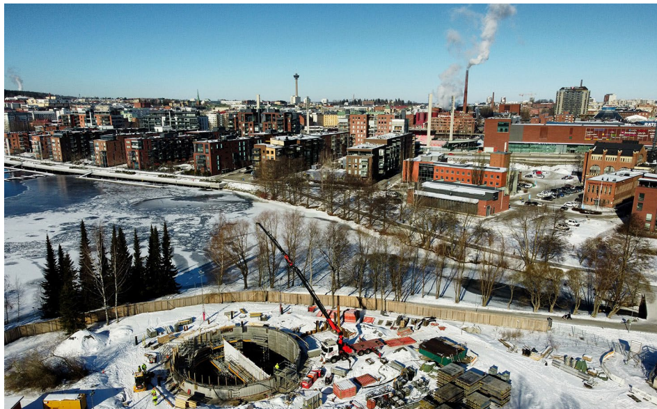
Ilmakuva Viinikanlahden pumppaamotyömaalta, kuva otettu maaliskuussa 2023. Kuva: Jouni Salminen, NYAB Finland Oy
