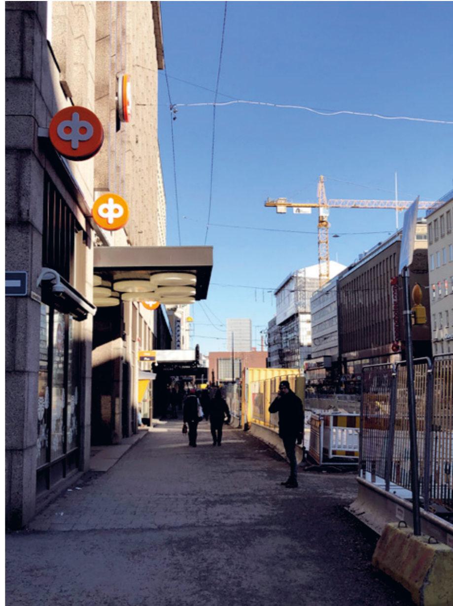
Tullikamarin ja Attilan tontin täydennysrakentamisella
