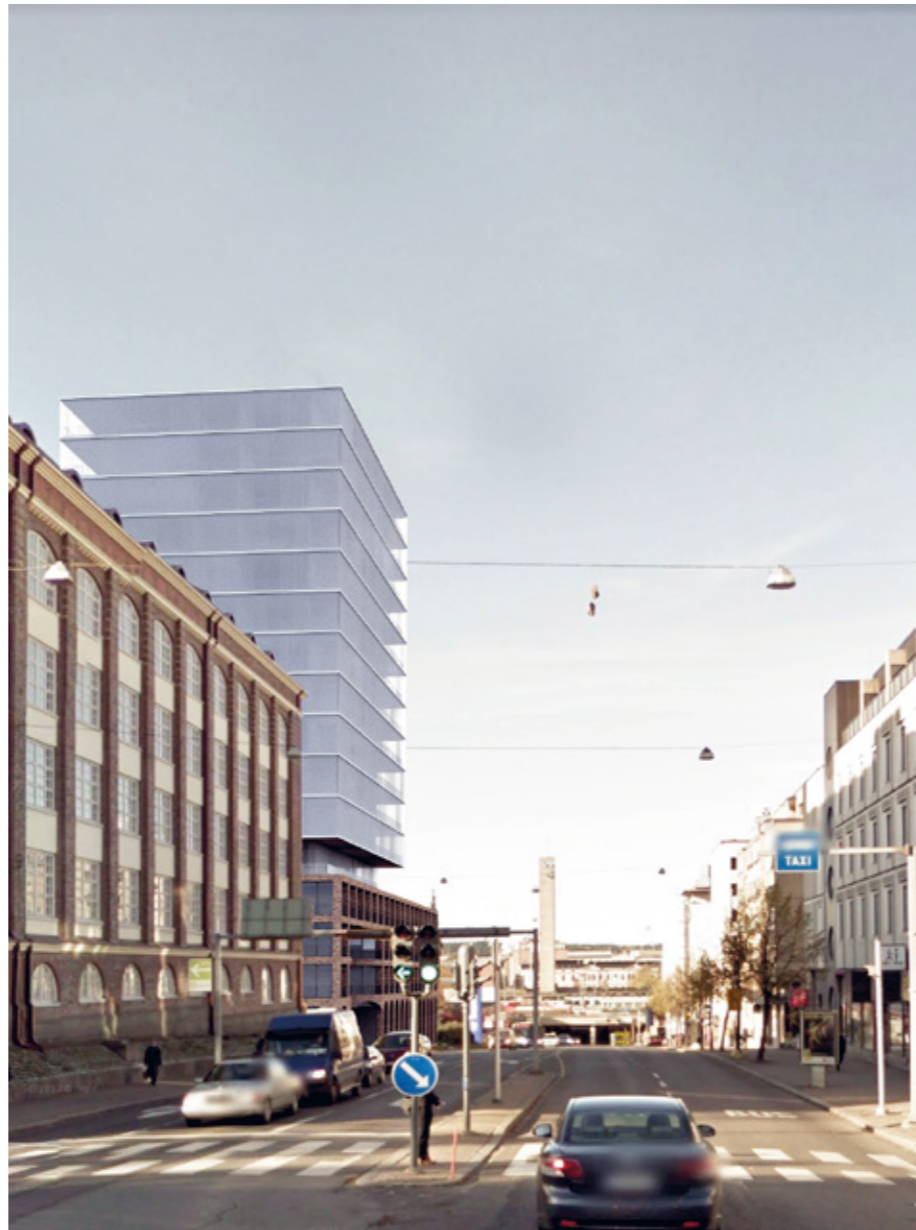
Tullikamarin ja Attilan tontin täydennysrakentamisella
