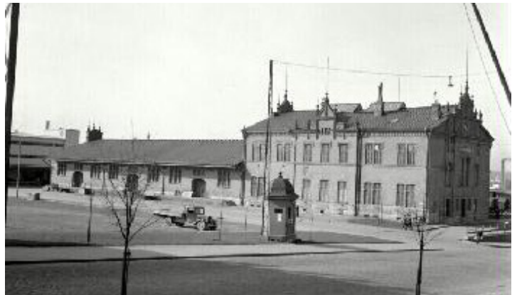
Tullikamari vuonna 1937 Itsenäisyydenkadun madaltamisen jälkeen. Tullin puolelle ei ollut itäjulkisivulla sisäänkäyntiä ja pakkahuoneen edessä oli lastauslaituri. Hammareninkatu jatkui Puolimatkan kadulle (nyk. Itsenäisyydenkatu) saakka. Myös aukiotilan suhde katutilaan oli suoraviivaisempi. Nykytilassa aukiota rajaavat Itsenäisyydenkadulta erilaiset katu- ja pysäköintilaitoksen toimintaan liittyvät rakennelmat. (Kuva: Arvo Tamminen, Tampereen museot)
