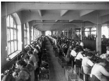
Attilan kenkätehtaan tehdassali 1910-luvulla. Pilari-palkkirakenne erottuu nykytilanteessakin rakennuksen avoimimmassa tiloissa. (Kuva: Niels Rasmussen, Tampereen museot)
