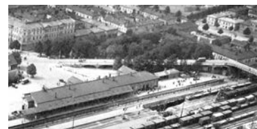
Tampereen vanha rautatieasema, toiminnassa 1876-1935. Rautatieaseman pohjoispuolella oli Tammelan silta, jota käytettiin rautatien ylitykseen rautatietunnelin valmistumiseen asti vuonna 1934. (Kuva: Tampereen museot).
