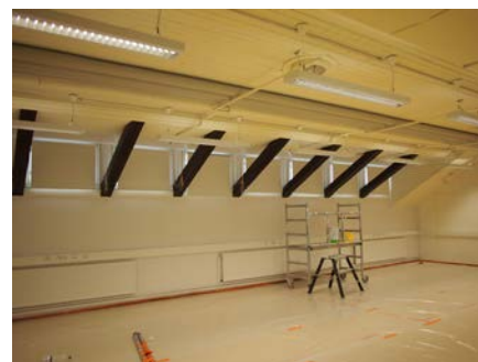
Kattorakenne näkyvillä ullakkokerroksessa.
