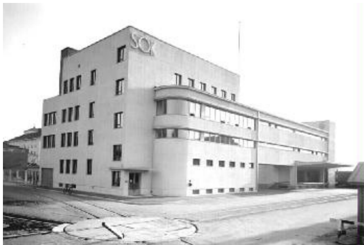
SOK:n rakennus heti valmistuttuaan vuonna 1936. Etualalla Tullin alueen sisäisen rataverkoston kääntöpyörä sekä raiteet Tullikadulle ja Hammareninkadulle. (Kuva: E. M. Staf, Tampereen museot)
