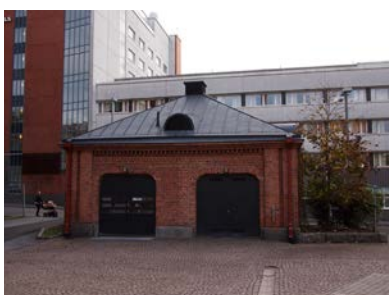
Entinen tallirakennus sisäpihan puolelta.
