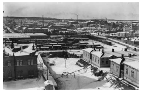
Itsenäisyydenkadun tunnelin työmaa vuonna 1933. (E.M.Staf, Tampereen museot)
