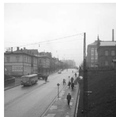
Itsenäisyydenkatu tunnelin rakentamisen ja kadun madaltamisen jälkeen. Kadun varren rakennukset jäivät huomattavasti katutasoa korkeammalle. (Kuva: Erkki Kauppila, Tampereen museot)
