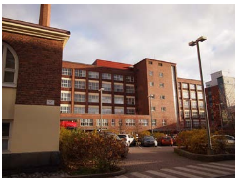
Vuonna 1954 rakentuneen osan julkisivua sisäpihan puolelta.
