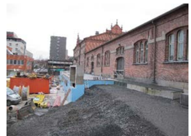
Pakkahuoneen aukion muutostöitä Hämpin Parkin rakentamisen yhteydessä. (Kuva: Miinu Mäkelä, Tampereen museot)
