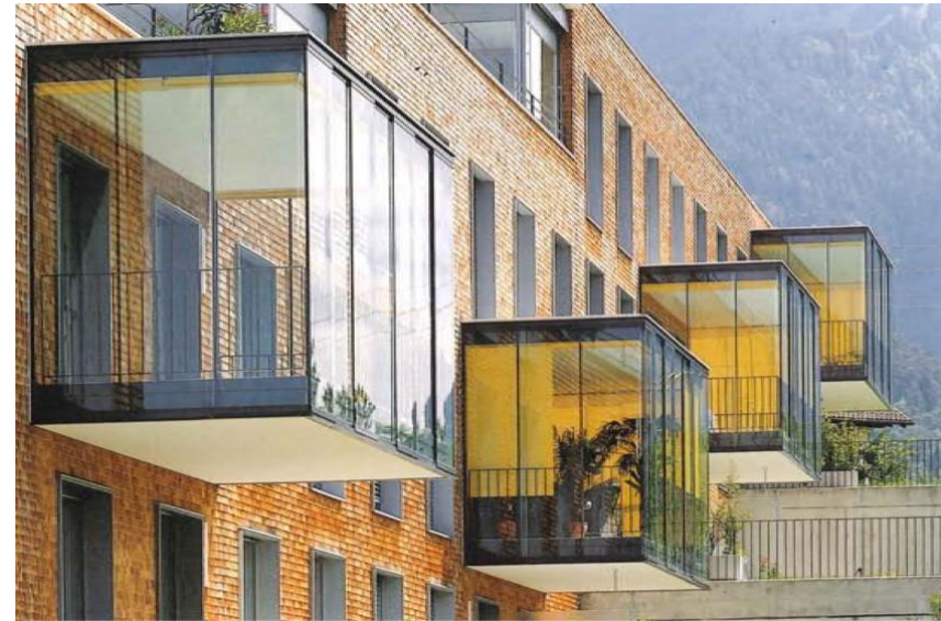
Esimerkki ripustettujen ulkonevien parvekkeiden sijoittelusta sisäpihan puolella. Baumschlager & Eberle, Nüziders, Itävalta. www.baumschlager-eberle.com .
