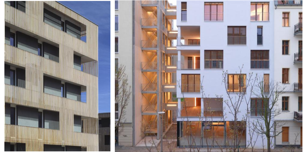
Esimerkki julkisivunomaisesta parvekevyöhykkeen käsittelystä. Baumschlager & Eberle, Mitterweg, Innsbruck. www.baumschlager-eberle.com .
