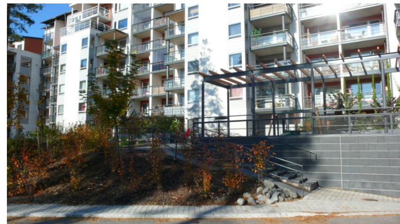
Kansipihan tasoerot tulee suunnitella huolellisesti penkerein, tukimuurein ja portain. Jos kannen seinäpintaa jää näkyviin, pinnan tulee olla viimeistelyä. Kuvan pihassa kaide on sovitettu yhteen pergolan kanssa. Kansipihat Helsingissä Vuosaaren Aurinkolahdessa. Kuvat LOCI maisema-arkkitehdit Oy.
