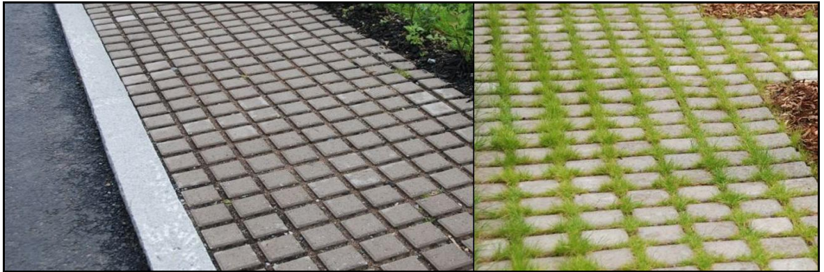
Kuva 24. Esimerkkejä läpäisevien päällysteiden käytöstä. Tampere, Vuores. 10
