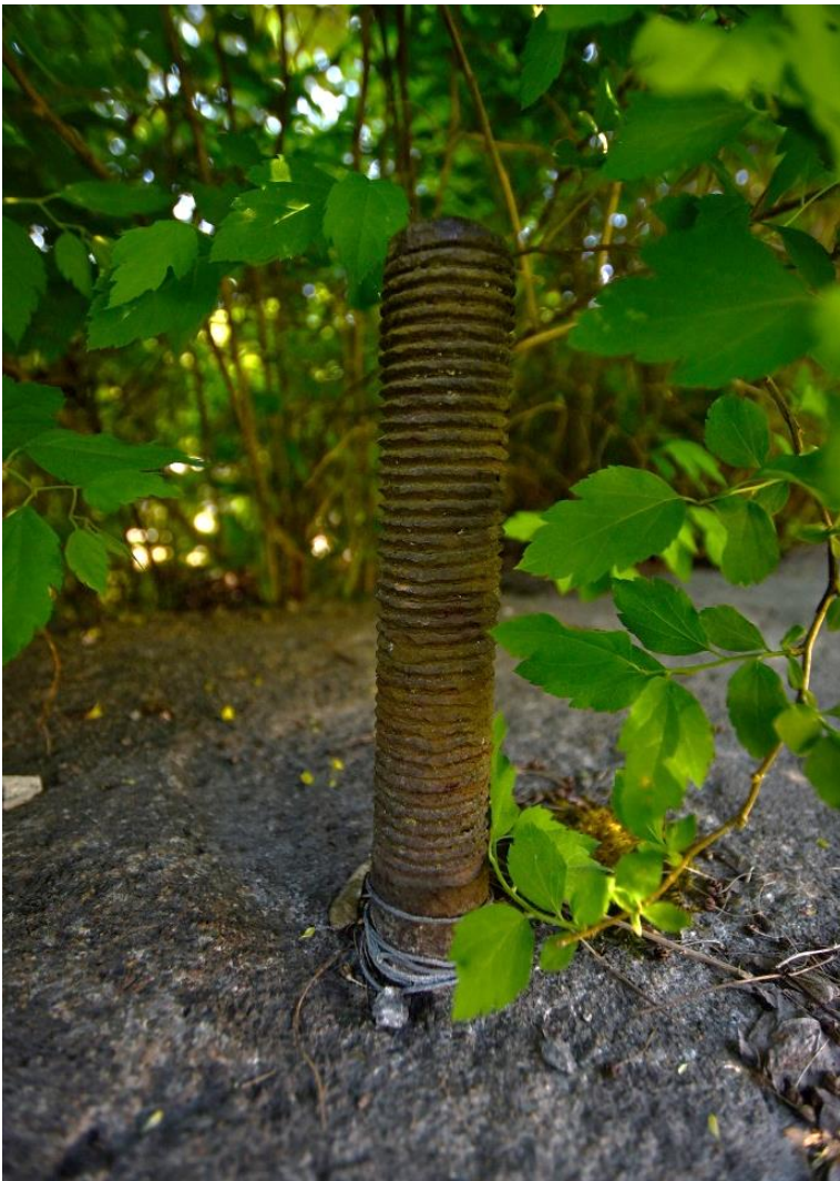
Kuva 23: Hammastettu rautapultti tukkitien betonianturassa (ennestään tunnettu kohde Pispalan tukkitie 1 ). Kuva: Ulla Moilanen, KY 291:14.
