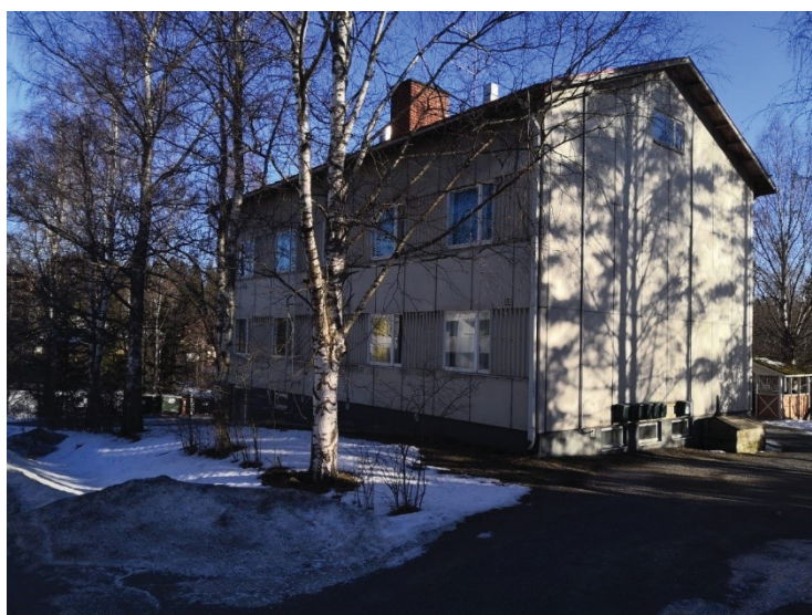
Kuva 4: Tontilla 4910-5 sijaitseva kaksikerroksinen pienkerrostalo. © Tampereen kaupunki 2021
