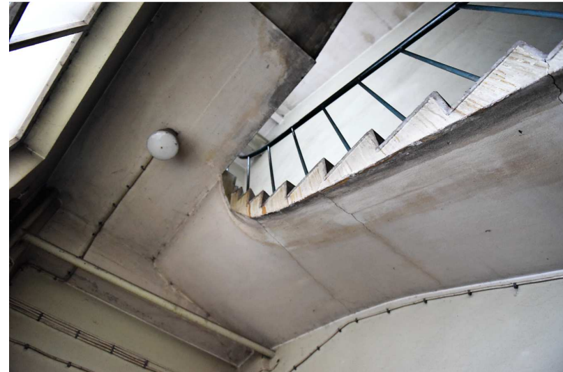
Kuva: Voimalaitoksen korkea porrashuone on vaikuttava tila paikalla valetuin betoniportain. Portaat ovat varustettu maalatuilla metalliputkikaiteilla.
