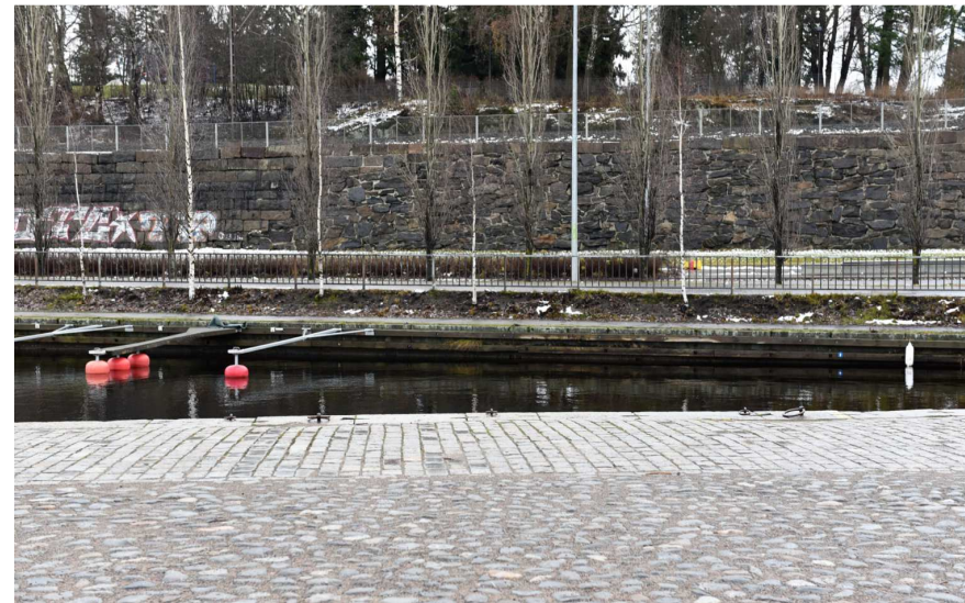
Kuva: Erilaiset luonnonkivipinnat luonnehtivat Mustanlahden satamaympäristöä. Laitureiden pintoja on ladottu nupu- ja mukulakivistä, kun taas tukimuureissa on käytetty suuria graniittikvaadereita. Vaikuttavaa kivrakentamista edustaa kaakossa nouseva ratapenkereen korkea kivimuuri.
