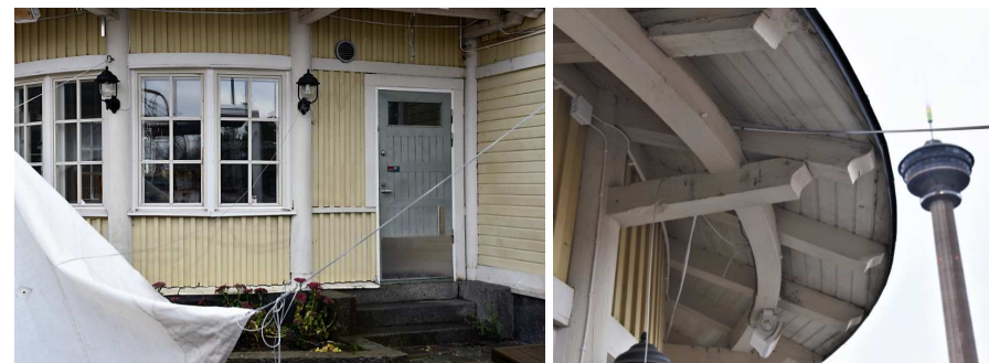
Kuva: Koillispäädyn pyöreässä osassa on uudet ikkunat.
