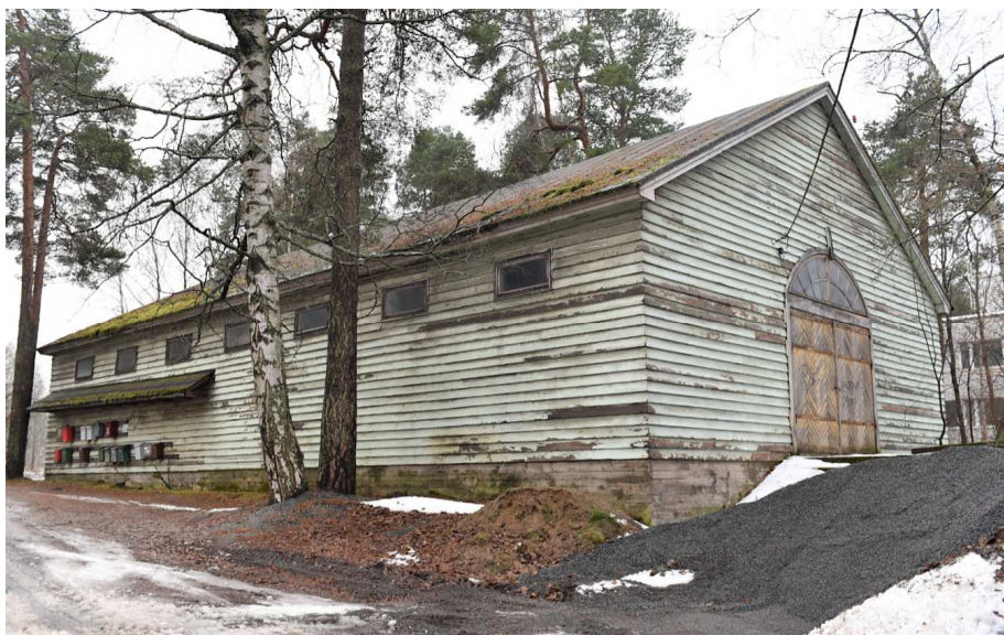
Kuva: Alun perin väliaikaisesti suunniteltu puurakenteinen, harjakattoinen, lämmittämätön varasto sijaitsee sisääntulopihan laidalla. Yksityiskohdiltaan klassistinen puurakennus poikkeaa punatiilisten rakennusten kokonaisuudesta.
