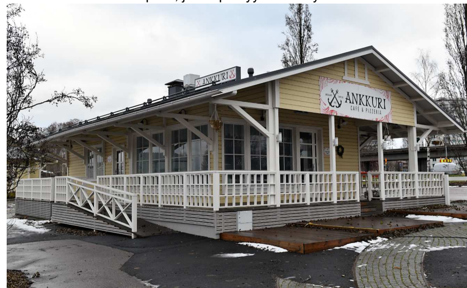
Kuva: Kahvilaa jatkettiin sivusuunnassa. Uutta osaa reunustaa jatkettujen katonlappaiden suojaama veranta. Ikkunat ovat suuremmat kuin vanhalla puolella.
