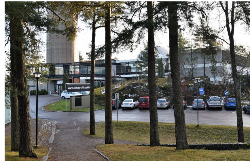
Kuva: Näsineulan pääsisäänkäynti on 1980-luvulla rakennetun kattokahvion alapuolella. Alkuperäinen vaakasuuntaisuus on säilynyt Akvaario-Planetaarion pohjoissivulla ja toimistosiiivessä.
