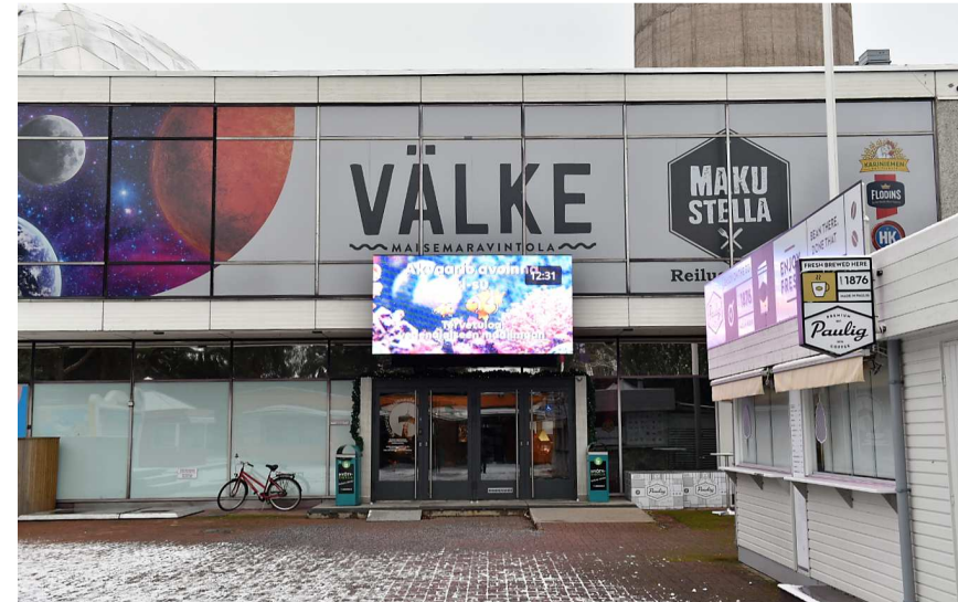
Kuva: Akvaario-Planetaarion eteläsivun arkkitehtonista ilmettä heikentävät ikkunoihin asennetut mainosteipit.
