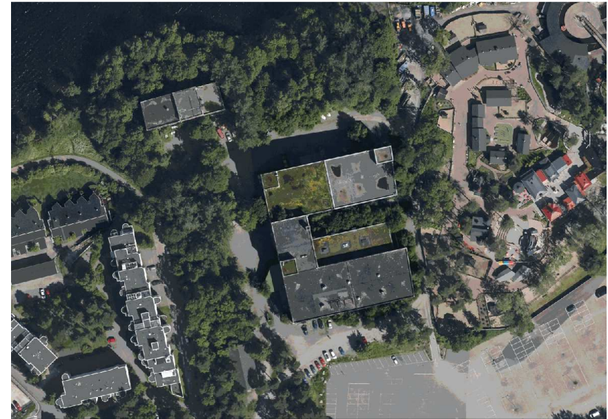
Kuva: Onkiniemen tehtaan pohjoissiiven katolla on mahdollisesti 50-luvulla tehty viherkatto, jollaisia jonkin verran tehtiin sotien jälkeen esim. tärkeiden yhdyskuntateknisten rakennusten maastouttamiseksi. 21 Siiven itäpuolen katto puhdistettiin ketokasvustosta joitakin vuosia sitten. Viherkaton kasvillisuus muodostuu sammalista ja ketokasvillisuudesta. //Ilmakuva 2015, Tampereen karttapalvelu.
