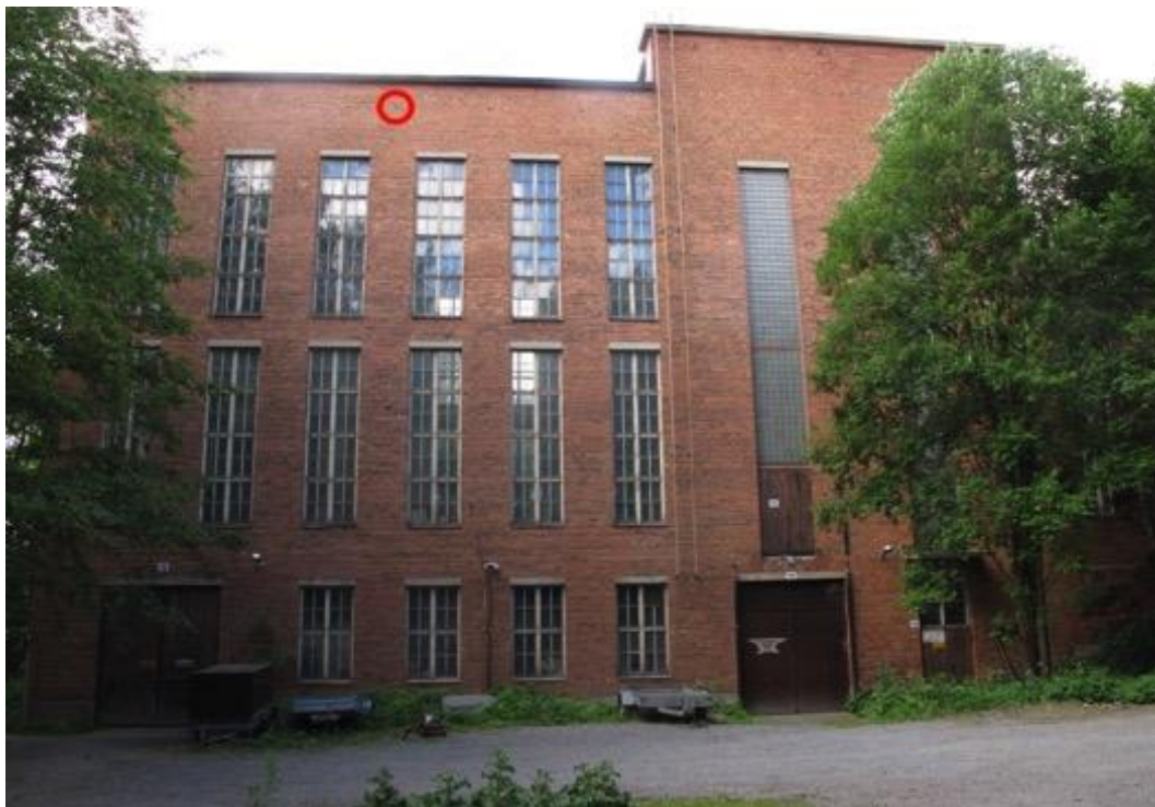
Kuva 8. Pohjanlepakkoyhdyskunnan todettu ulostuloaukko voimalarakennuksen eteläseinällä on merkitty punaisella ympyrällä. Kyseessä on tiiliputki kolmannen ja neljännen ikkunarivin välissä.
