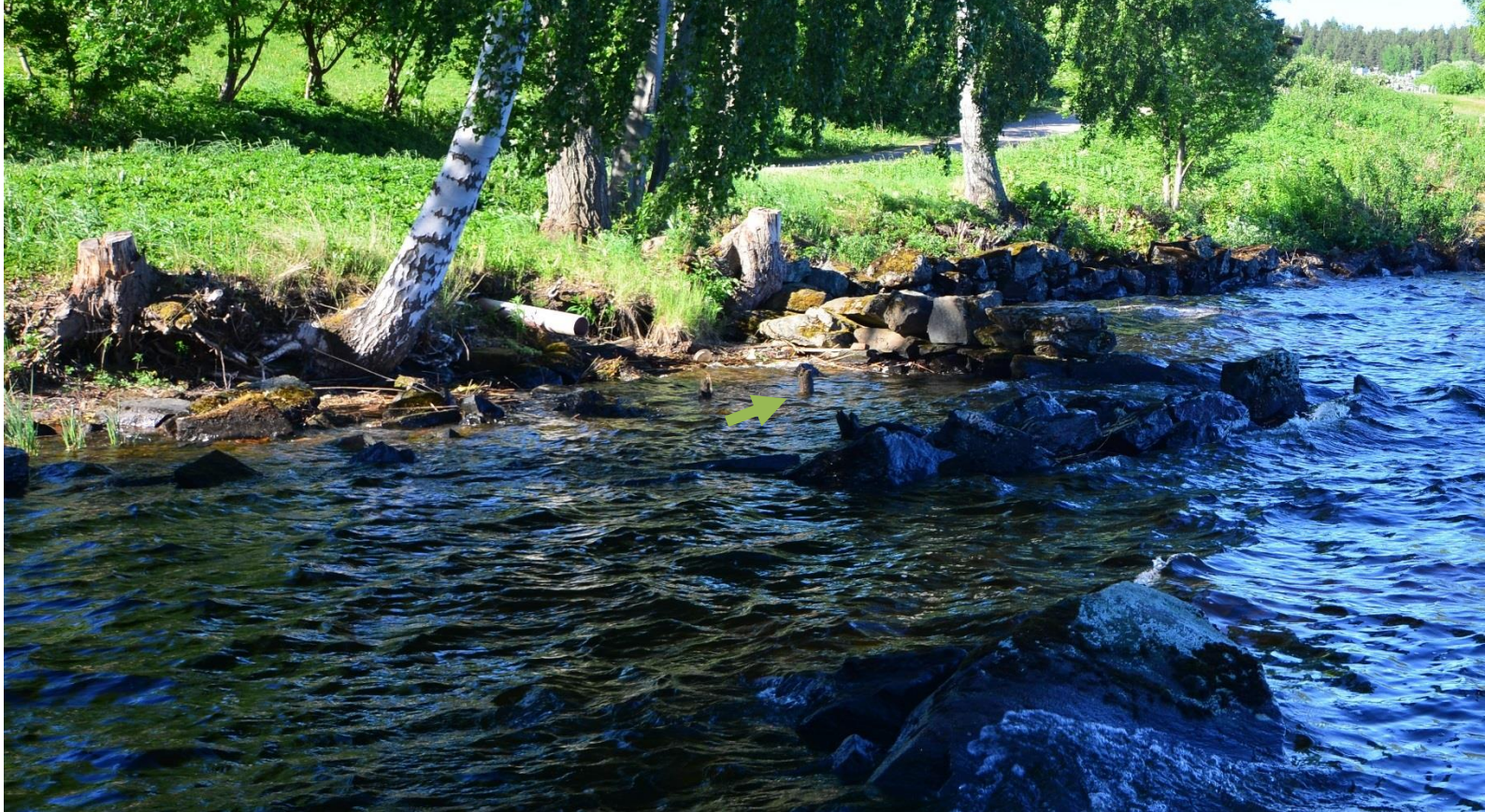
Kuva 6: Onkiniemen rannassa sijaitseva kivirakenne idästä. Kuva: Ulla Moilanen, KY 296:2. Vedestä esiin pistävä puutolppa on merkitty kuvaan nuolella.
