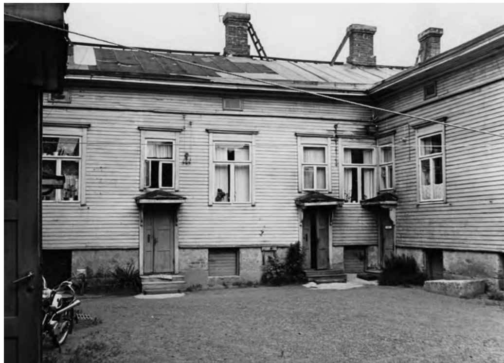
Vasemmalla: Sisäpihanäkymä Mäkipäänkadun korttelin sisältä juuri ennen korttelin purkamista. Huomaa upouusi Puch-moottorinen vuoden -66 mallin Tunturi Sport -mopo.
