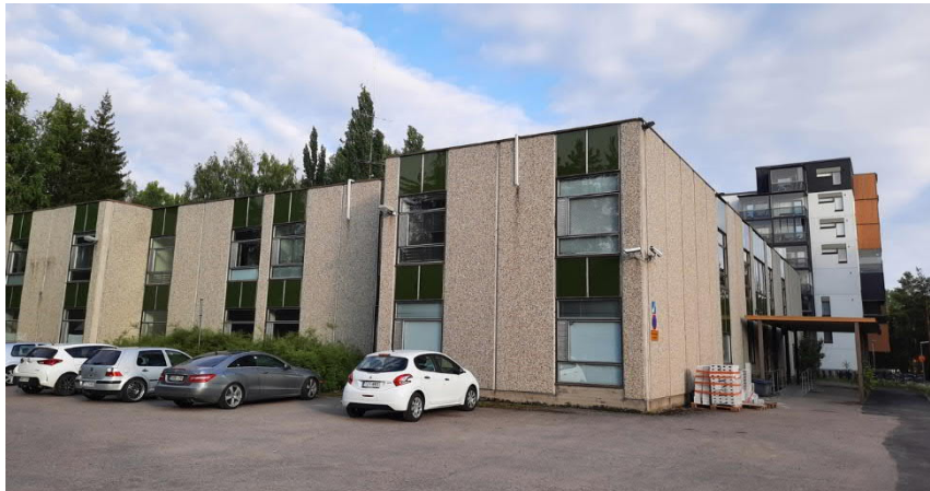
Kuva 3: Suunnittelualueelta vuonna 2021 purettu lukiorakennus. Tampereen kaupunki 2020.
