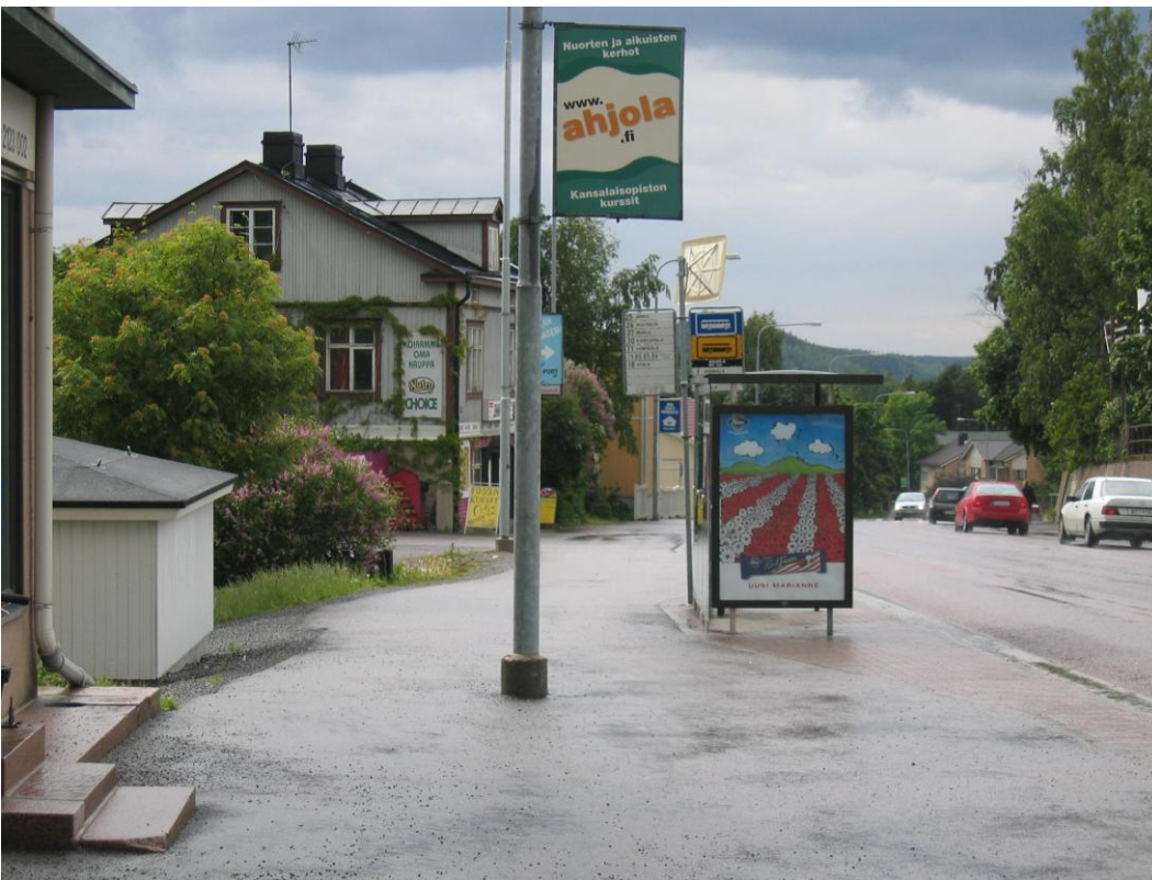
Kuva 3.10. Valopylväs keskellä kevyen liikenteen väylää.
