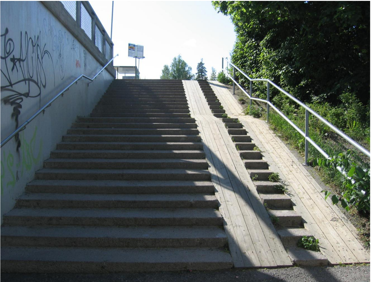
Kuva 3.5. Pispalan valtatie alikululle johtavat portaat.
