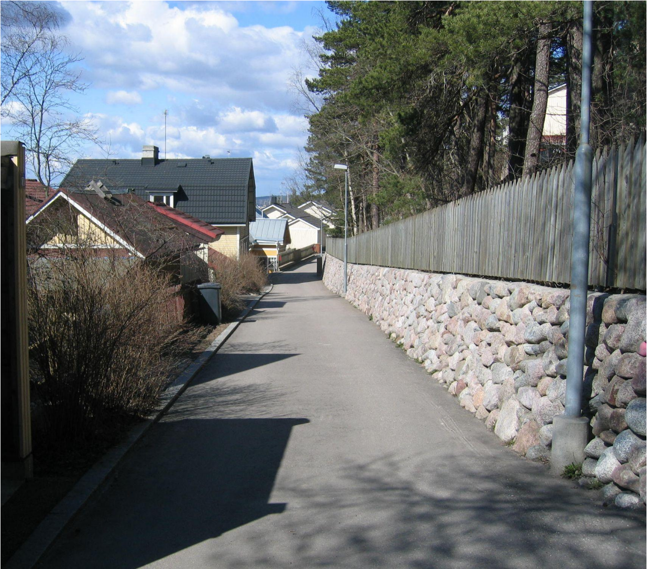
Kuva 2.3. Kapea Provastinkatu tukimuureineen.
