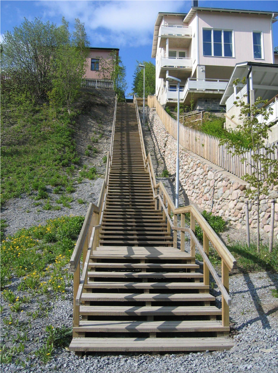
Kuva 3.4. Portaat Mäkikadun ja Rinnekadun välissä.
