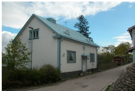
Klassispiirteinen asuinrakennus 1930-luvun alusta Mäkikadun varressa.
