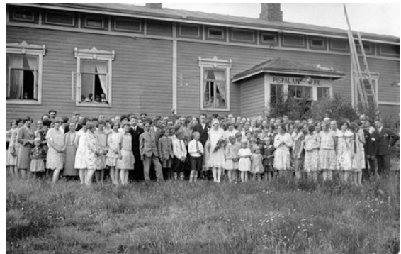
1880-luvulla rakennettu Pispalan VPK:n talo. © Kalle Kurki, Tampereen museoiden kuva-arkisto.
