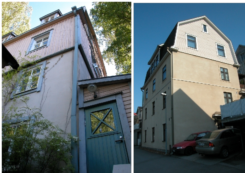
Rinteen jyrkkyydestä johtuvia Pispalalle tyypillisiä rakennusteknisiä ratkaisuja.
