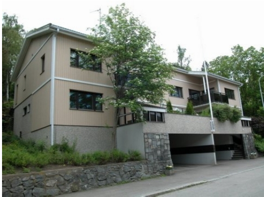
19. Varalankatu 13 paritalo pohjoisesta.
