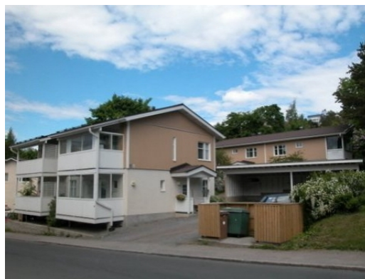
14. Tahmelankatu 12 asuinrakennukset etelästä (rak. 1999).
