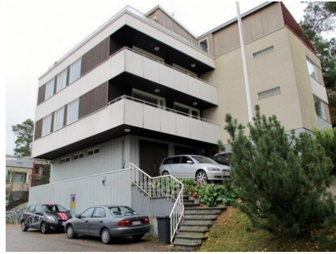
Moderni 1960-luvun kerrostalo Suuruspäänkadulla.
