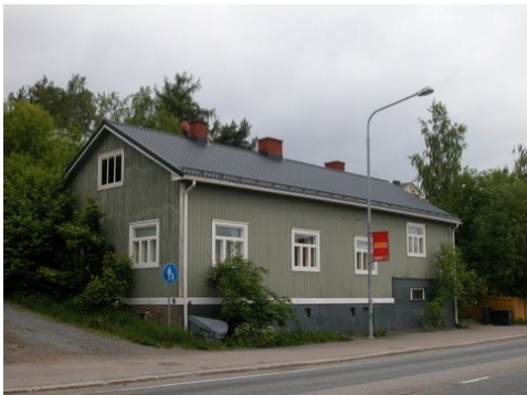
Kaupunkipuutalotyypinen asuinrakennus Pispalan valtatievarressa.
