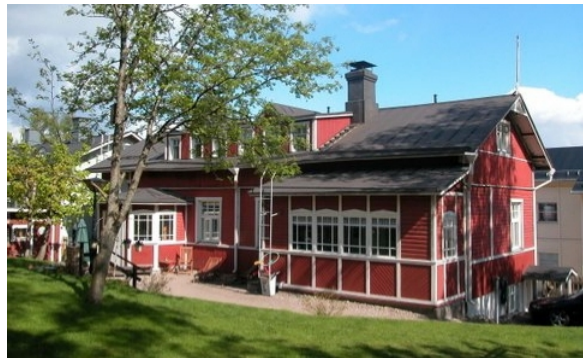
Mäkikadun varressa sijaitsevan kaupunkipuutalon pihasisi.
