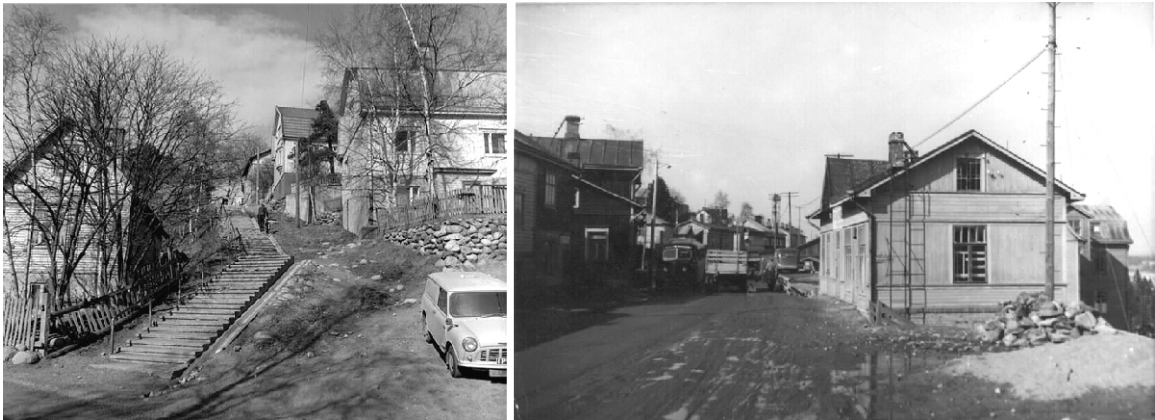
Vasemmalla Päivölänkadun betoniporaat 1950-60-luvulla. Oikealla Pispalan valtatie levennystöitä 1950-luvulla. Oikean reunan rakennus, ns. Vanamon kauppa purettiin levennyksen tieltä. Kuvat: Tampereen museoiden kuva-arkisto.
