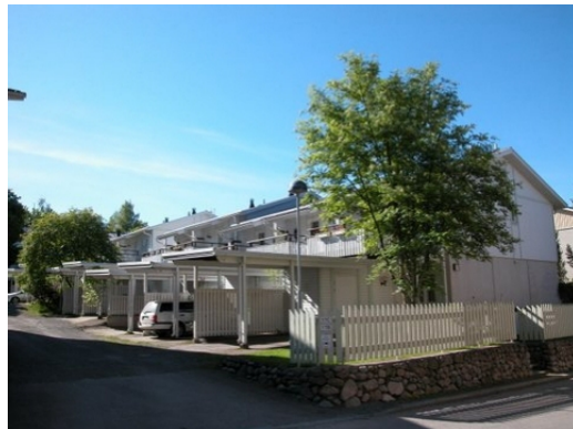
6. Hirvikatu 17 / Tahmelankatu 11 rivitalot pohjoisesta (rak. 1985).
