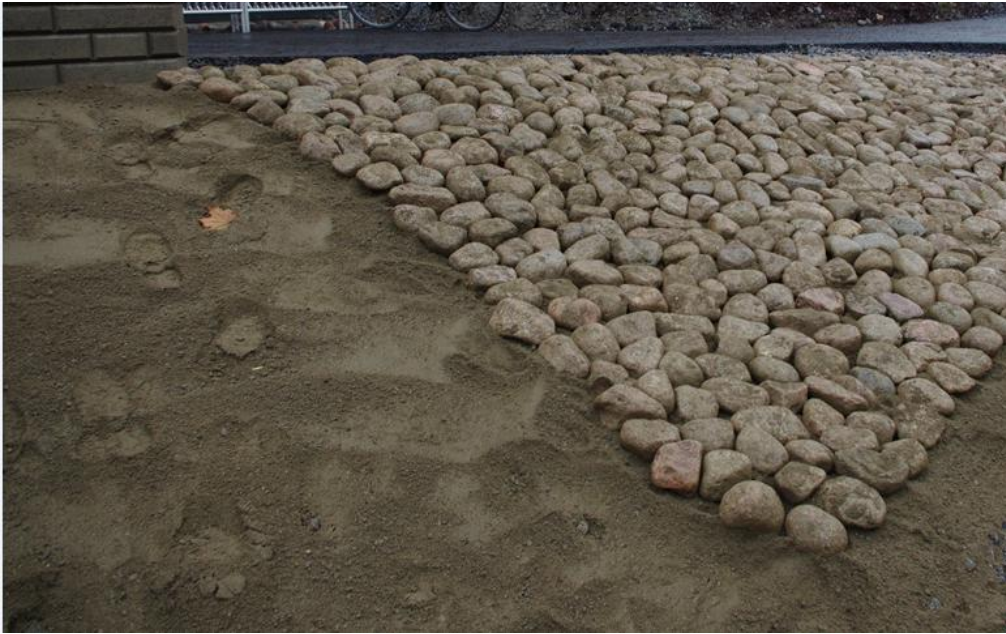
Kuva 5. Esimerkki kuva jyrkimmän rinneosuuden eristämisestä.
