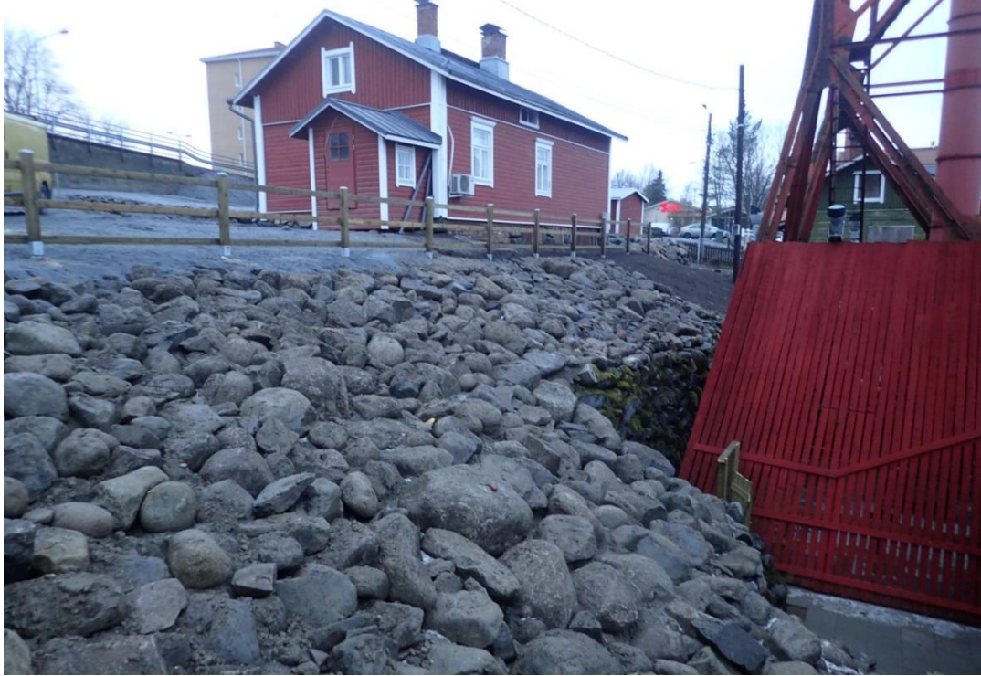
Kuva 3. Kuva jyrkimmän rinneosuuden eristysratkaisusta, jossa pohjalta on poistettu eloperäinen aines, täytetty murskeella ja pinnoitettu maakostealla betonilla sekä erikoisilla luonnonkivillä.
