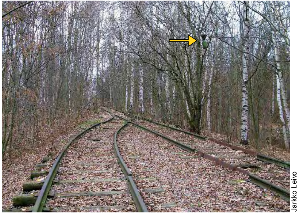
Kuva 8. Syöttirysä E raitapajussa Uittotunnelin notkon lehtipuualueella.
