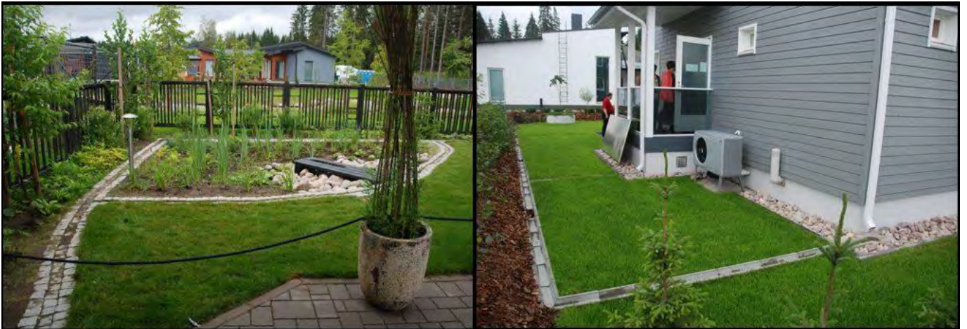
Kuva 25. Omakotitalon hulevedet johdetaan maanpäällisin kouruin tontin kulmassa olevaan sadepuutarhaan, joka mahdollistaa hulevesien hetkellisen lammikoitumisen. (Tampere, Vuores).
