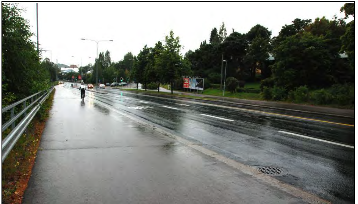
Kuva 11. Pispalan valtatie asfalttipäällysteisen katualueen leveys on monin paikoin noin 16 metriä. Katualueella muodostuu paljon hulevesiä. 10
