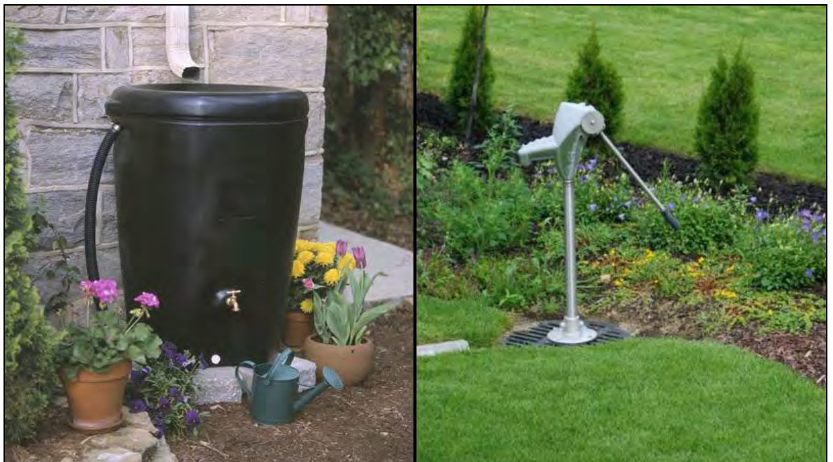
Kuva 26. Vasemmalla esimerkki 190 litran kattovesisäiliöstä. Oikealla tontin hulevesille varattu kaivo, josta vedet pumpattavissa hyötykäyttöön.
