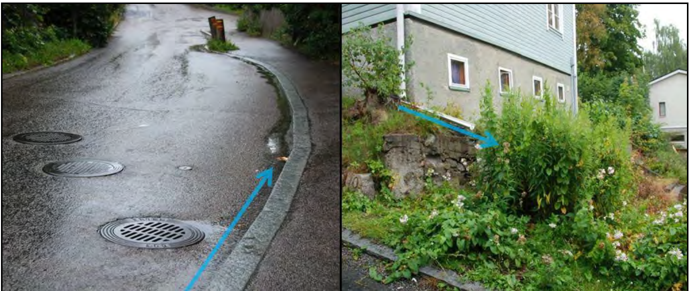
Kuva 7. Usein toistuvia ongelmia. Vasen kuva: katualueen hulevesikaivot liian kaukana reunakivestä. Oikea kuva: rakennusten hulevesiä johdetaan hallitsemattomasti ympäristöön tai viereiselle tontille. Rinnemaastossa tämä aiheuttaa eroosiota ja voi johtaa kosteusongelmiin. 10
