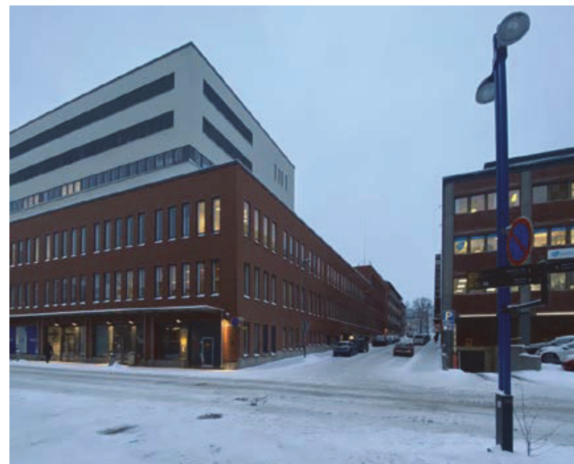
Kuvateksti: Valokuva rakennuspaikasta Åkerlundin kadulta Sumeliuksenkadun suuntaan kuvattuna.
