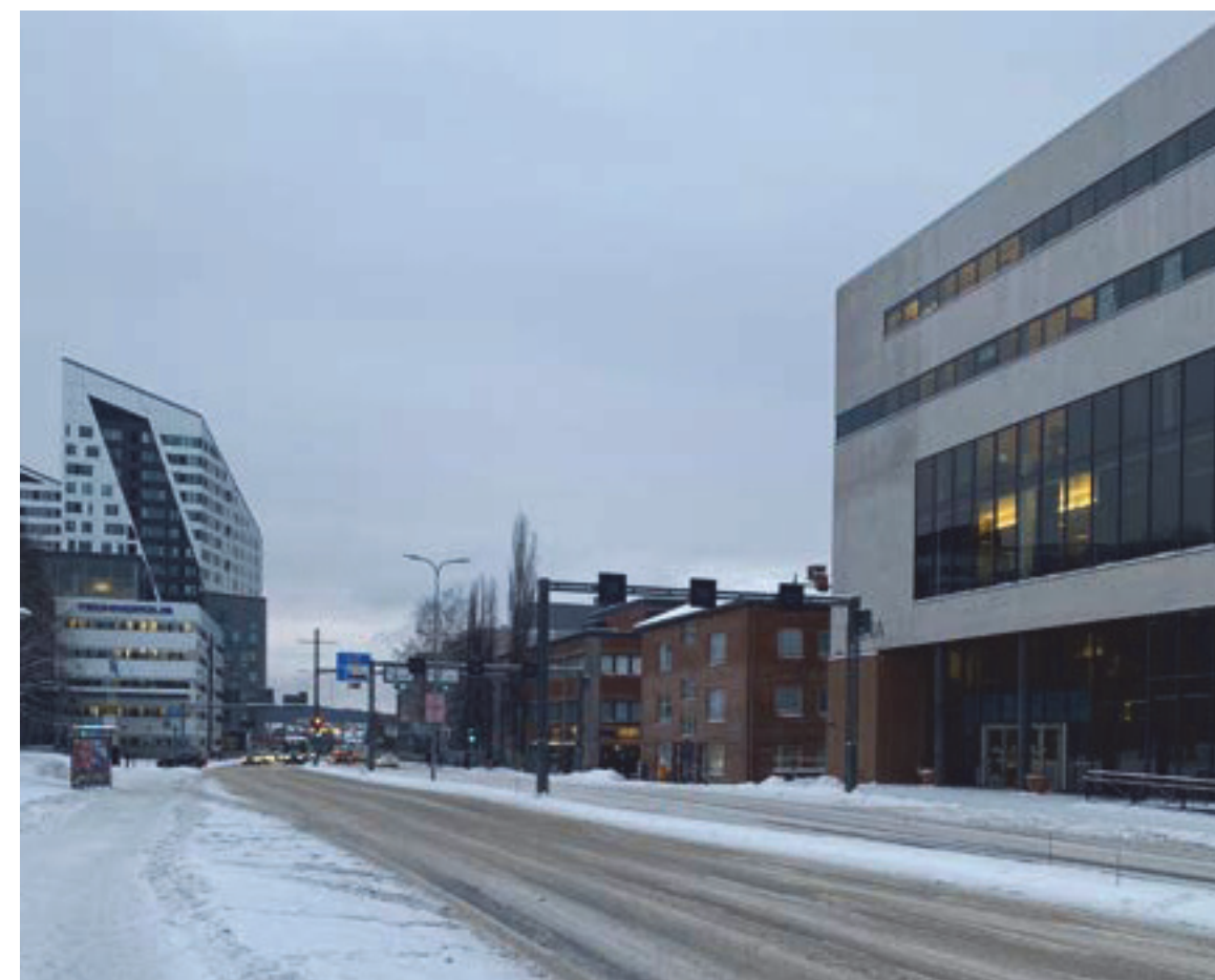
Kuvateksti: Valokuva rakennuspaikalta Kalevantieltä kuvattuna.
