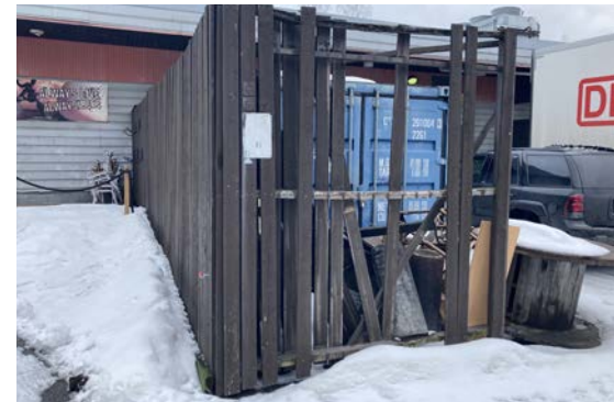
Osa Männistökuja lastauspihan alkuperäisistä lauta-verhoiluilla aidoista ja katoksista on todella huonossa kunnossa (kuva 26).
