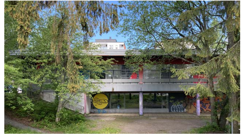
Yllä: Kesäaikaan puiden siimekseen piiloutuvaa eteläjulkisivua hallitsee toisen vaiheen laajennuksessa tehty betoninen kävelytaso (kuva1). Vasemmalla: Vuonna 1976 laajennettua toisen vaiheen ostoskeskusosaa kiertää järein betonikaitein rajattu terassi (kuva2).
