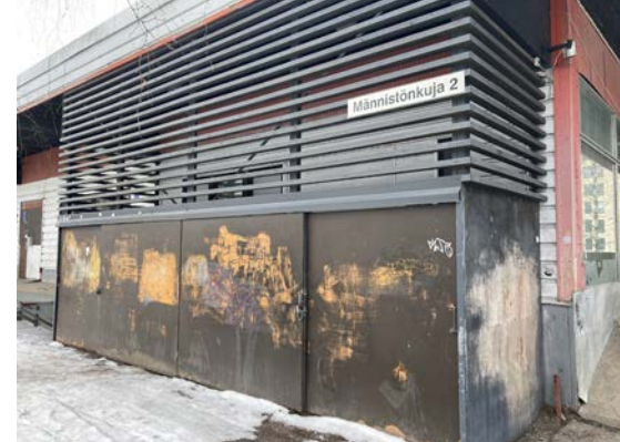
Arkkitehtikonttori Petri Pussisen vuonna 2001 suunnittelema varastokatos Männistökujan alkupäässä (kuva 23).
