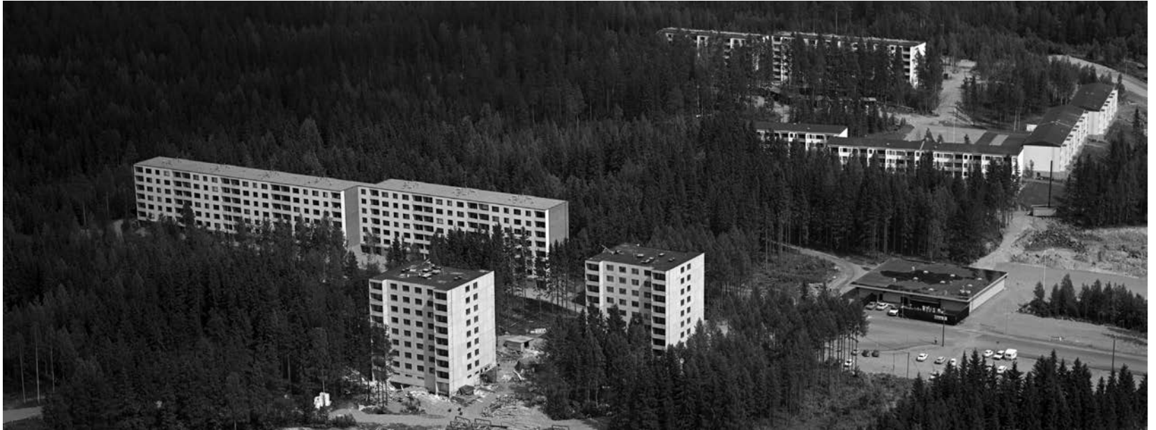
Noin vuonna 1972-1973 kuvattu Keskus-Sato Oy:n rakentama ja sen suunnittelijoiden Olavi Heikkilän ja Matti Peltosen piirtämä myymälärakennus. Huomaa myös kestopäällysteinen Männistökuja. Lähde: Siiri Kuva-arkisto.
