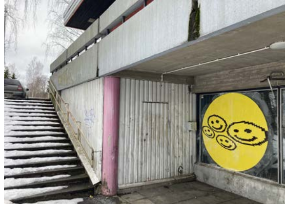
Kellarikerroksen ulkoportaiden yhteyteen on rakennettu varastotila 2000-luvun alusta (kuva 22).
