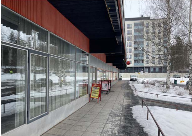
Halkoniemenkadun julkisivu on melko alkuperäinen. Julkisivulta on poistettu vuonna 1989 asennettu pankkiautomaatti (kuva 17).
