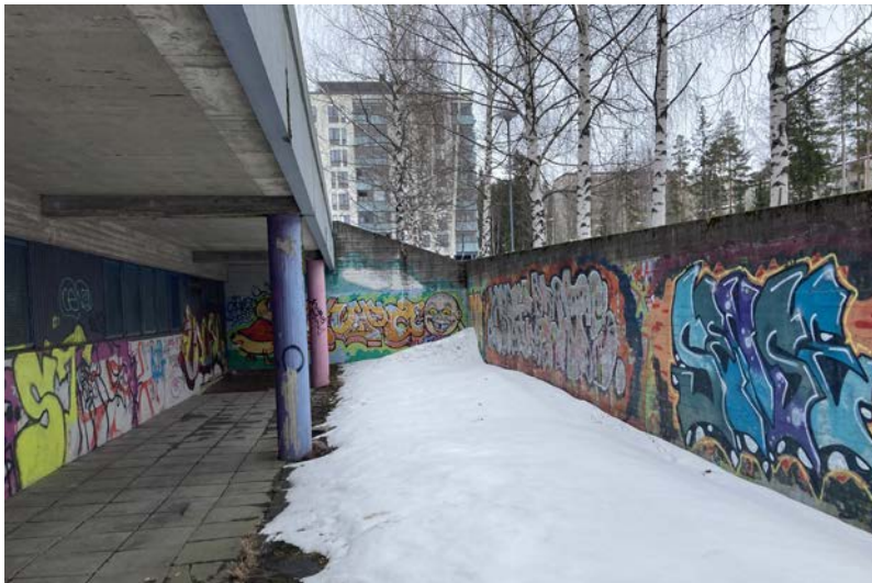
Yllä ja yllä oikealla: Kellarikerroksen entisten nuorisotilojen betonijulkisivuja on töhritty toiminnan loppumisen jälkeen (kuva 19 ja 20).
