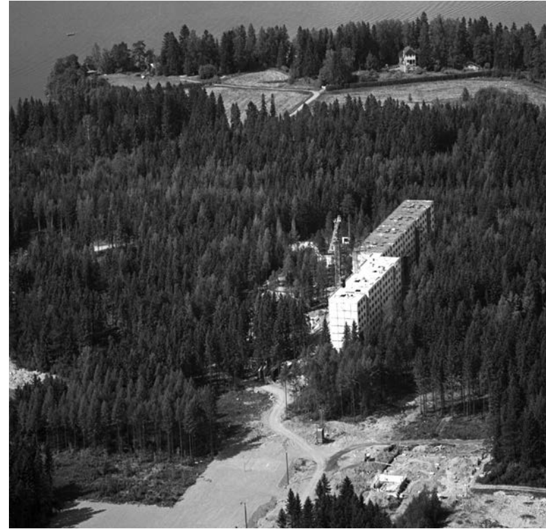
Lentävänniemi kuvattuna kohti pohjoista vuoden 1971 vaiheilla, Männistönkujan päähän rakenteilla olevat Mattinen-Niemen toteuttamat kerrostalot sekä ostoskeskuksen kellarin perustusten tekoa. Lähde: Vapriikin SIIRI kuva-arkisto
