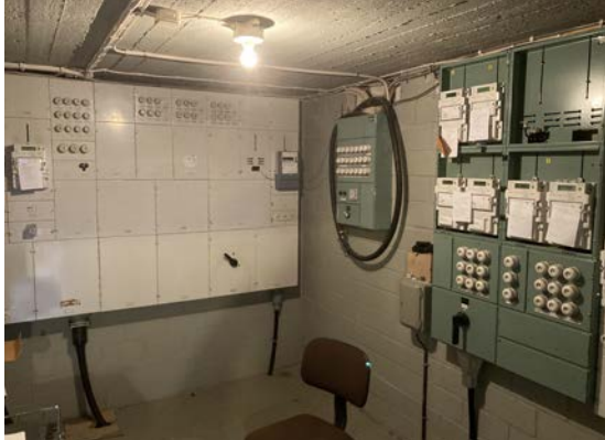
Sähköpääkeskus on lähes alkuperäisessä kunnossa (kuva 21).
