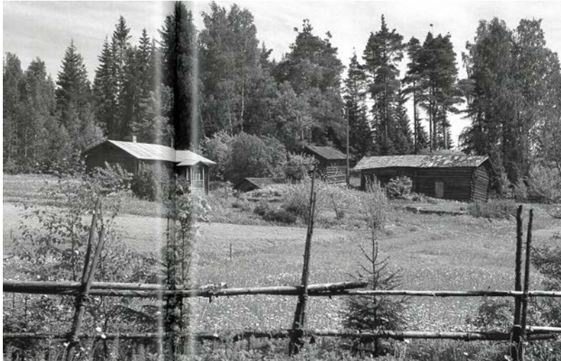
Mäntylän torppa kuvattuna sen pihan eteläpuolelta kulkeneelta Halkoniementien/Lielahdentien kohdalta, jonka länsipuolelle (kuvassa vasemmalle) uusi ostoskeskus rakennettiin. Torppa purettiin vasta 1970-luvun taitteessa. Kuva: Simo Lehtonen
