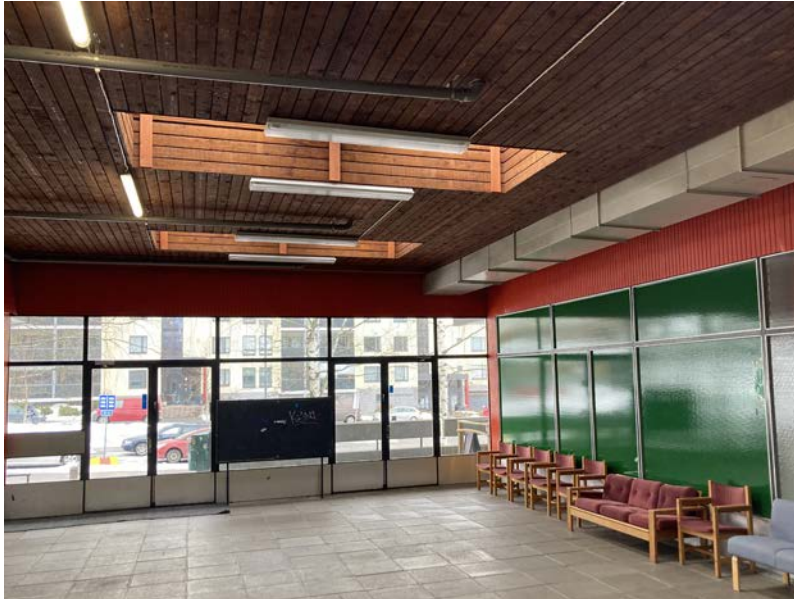
Lentävänniemen ostoskeskuksen toisessa vaiheessa toteutettu kattoikkunoilla varustettu atriumpiha, johon on lisätty ilmastoinnin koteloiteja (kuva 13).
