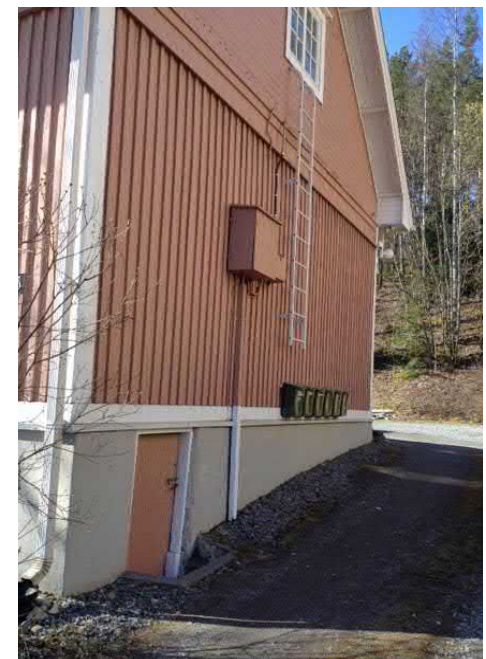
Hyvin suunniteltuna nykyaikainen talotekniikka voidaan toteuttaa historiallisessa ympäristössä lähes huomaamattomasti. Yläkuvassa ilmalämpöpumpun suojakotelo ja alakuvassa tekninen laite sekä johto rakennusaineisessa, julkisivun väriin maalatussa kotelossa.
