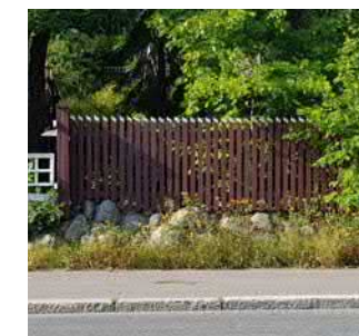
Puusäleaita yhdistettynä pulterimuriin Pispalan valtatiellä
