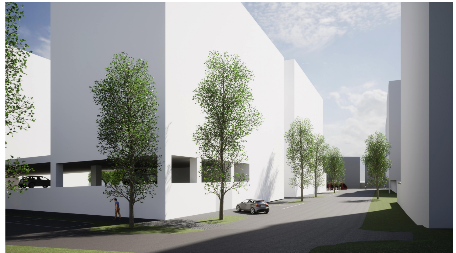
Näkymä Männistökujalta etelään
