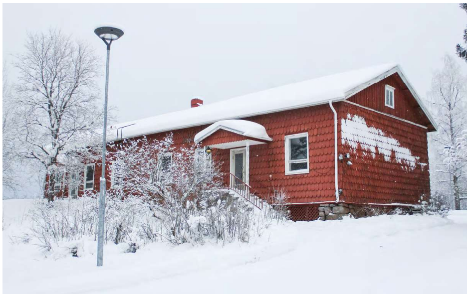
Vanha päärakennus idästä kunnalliskodin suunnasta.
