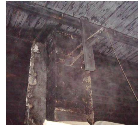
Hormin peltien säätelyjärjestelmä. Puuosissa näkyy kosteusvaurioita.
