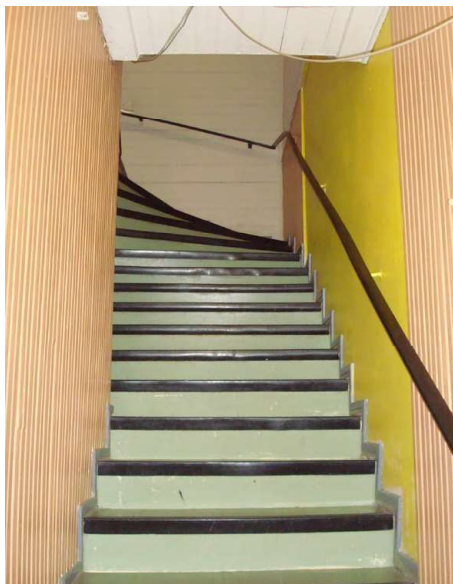
Alkuperäinen portaikko ullakolle ja keittiösiiven asuntoon.
