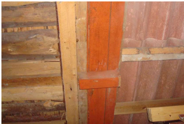
Ullakon luoteispäädyssä näkyy laajennusosan liittyminen vanhaan osaan. Ruodelaudassa on vuosilukukin kirjattuna.
