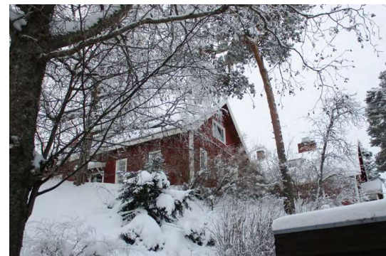
Rakennus kuvattuna saunan edustalta.
