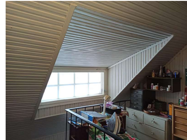
Portaikon kattoikkuna vaikuttaa olevan paremmassa kunnossa kuin koillispäässä.
