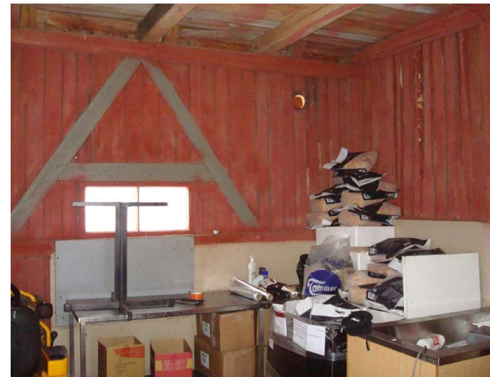
Kaakkoispäädyn tilassa seinät on sisältäkin maalattu punaisiksi.
