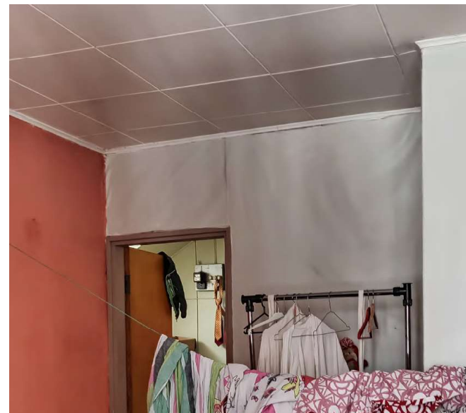
Keittiön yläpuolisen asunnon katto on huokoista kuitulevyä. Seinien pinkopahvit ovat löystyneet.
