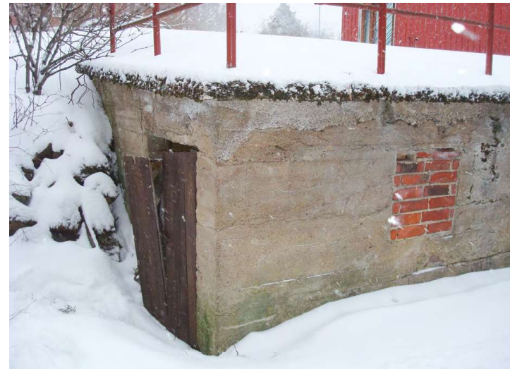
Oikealla: Kellarin rikkinäinen ovi ja umpeen muurattu ikkuna.
