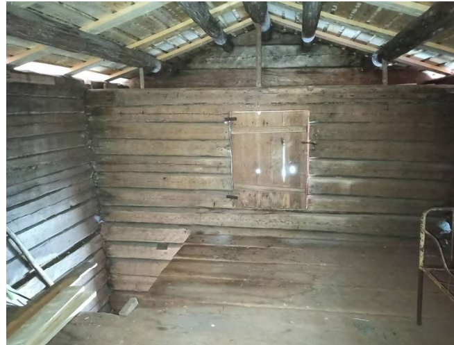
Aitan toinen kerros on tyhjillään. Kattoa on uusittu.
