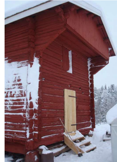
Aitan uusi ovi ja portaat
