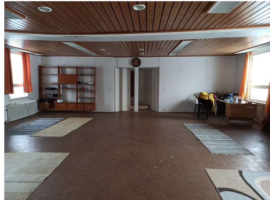
Rakennuksen keskeltä on purettu poikittainen hirsiseinä. Katto on notkahtanut ja lattiat viettävät.
