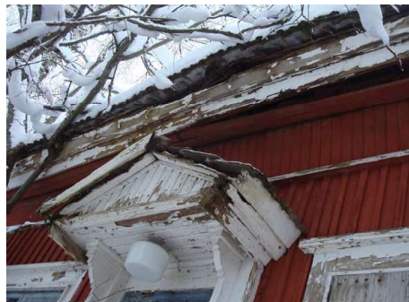
Kaakkoispuolen sisäänkäynnin kohdalla räystäs on rikkoutunut. Sisäänkäyntikatosten frontonit ovat aikoinaan olleet huolella tehtyjä.
