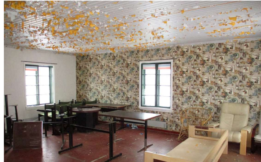
Luoteispään kamarin lattia on maalattua kovalevyä. Katon maalityypin valinta ei ole onnistunut optimaalisesti.
