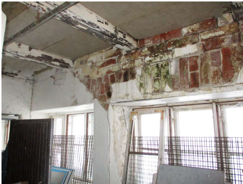
Lounaan puoleista ulkoseinää rakennuksen keskivaiheilta.
