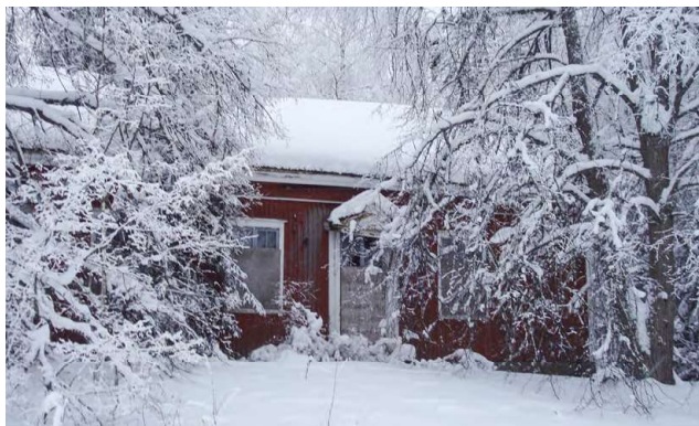
Luoteisjulkisivua puiden katveessa.
