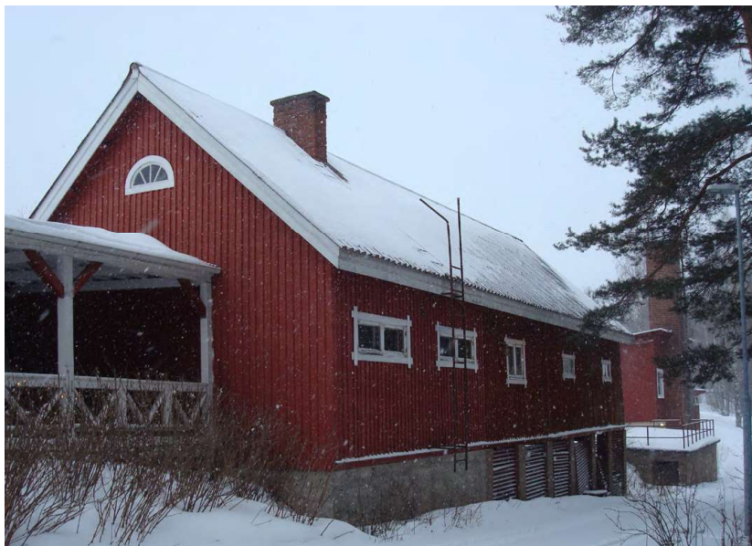
Luoteispäädyssä on saunalaajennus, jonka alueella on umpisokkeli.
