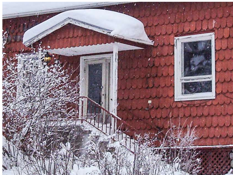
1960-luvun alun uusi sisäänkäynti ja "ajanmukaistettu" ikkuna.
