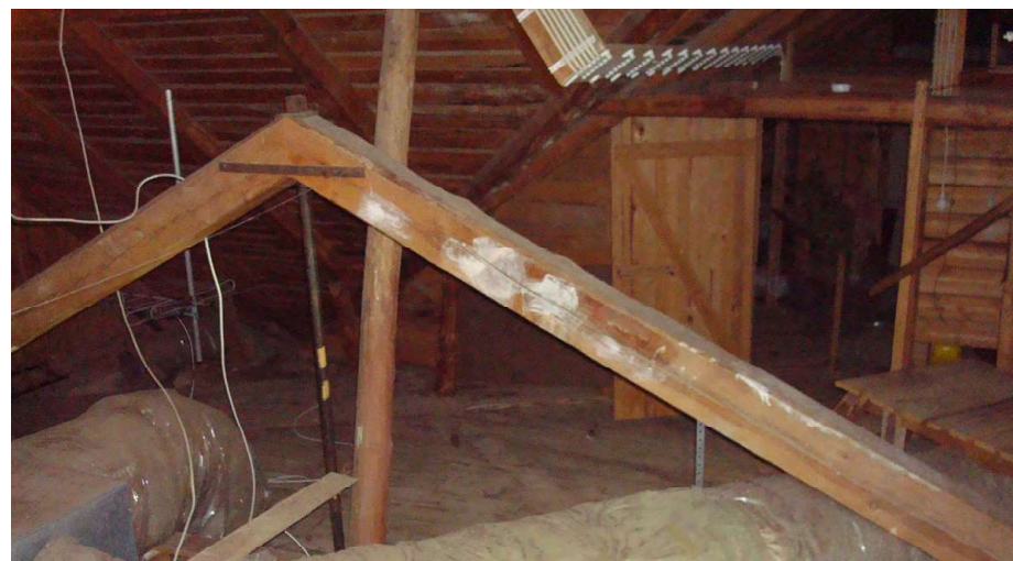
Salin kattoa kannattava ansasrakenne ullakolla vastaa alkuperäistä v. 1913 laadittua leikkauspiirustusta.
