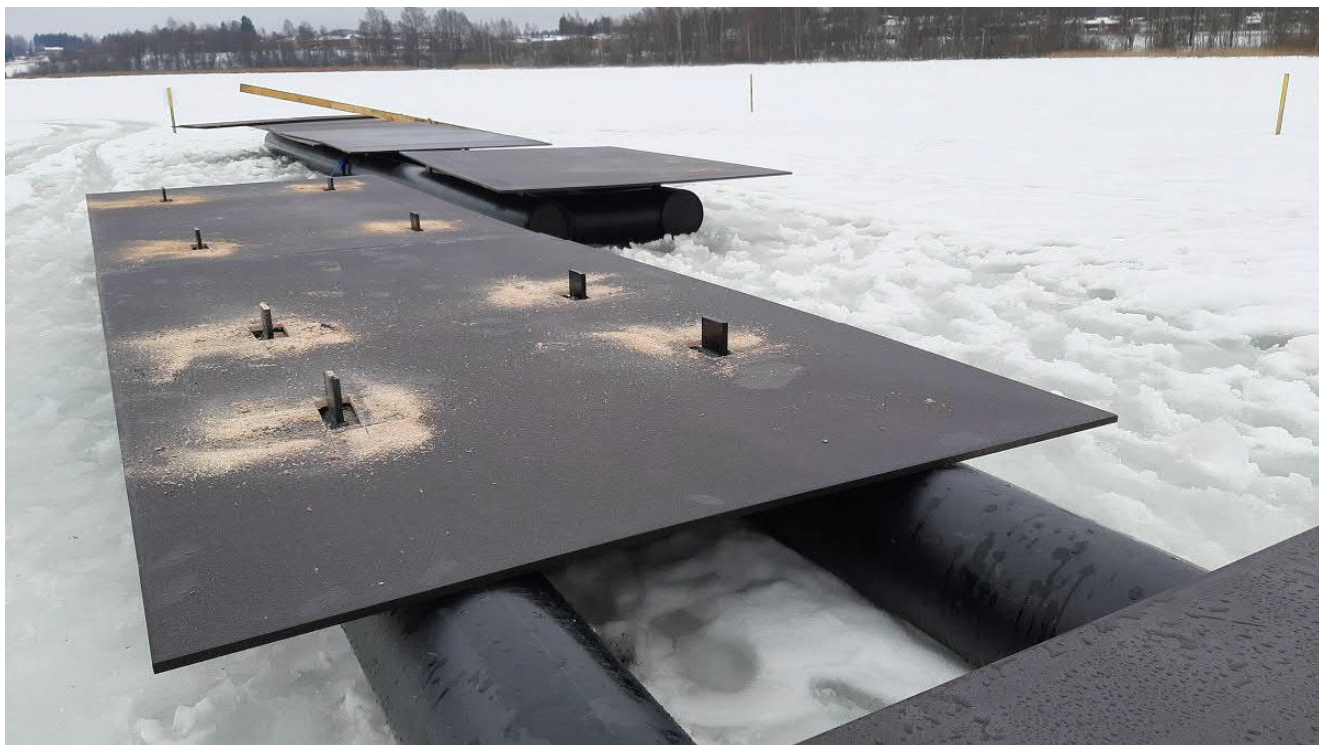
Kuva 2. Lautan rakenteet. Ponttoonien päälle rakennettiin vesivanerilevyistä tasot.
