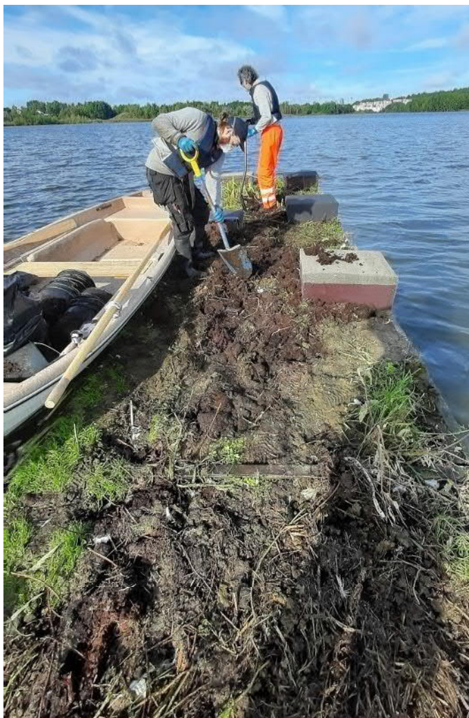
Kuva 7. Syksyllä 2022 lautoilta poistettiin osa kasvualustasta ja kasvillisuudesta, sekä asennettiin pesälaatikoita sotkien ja sorsien pesintää edistämään.
