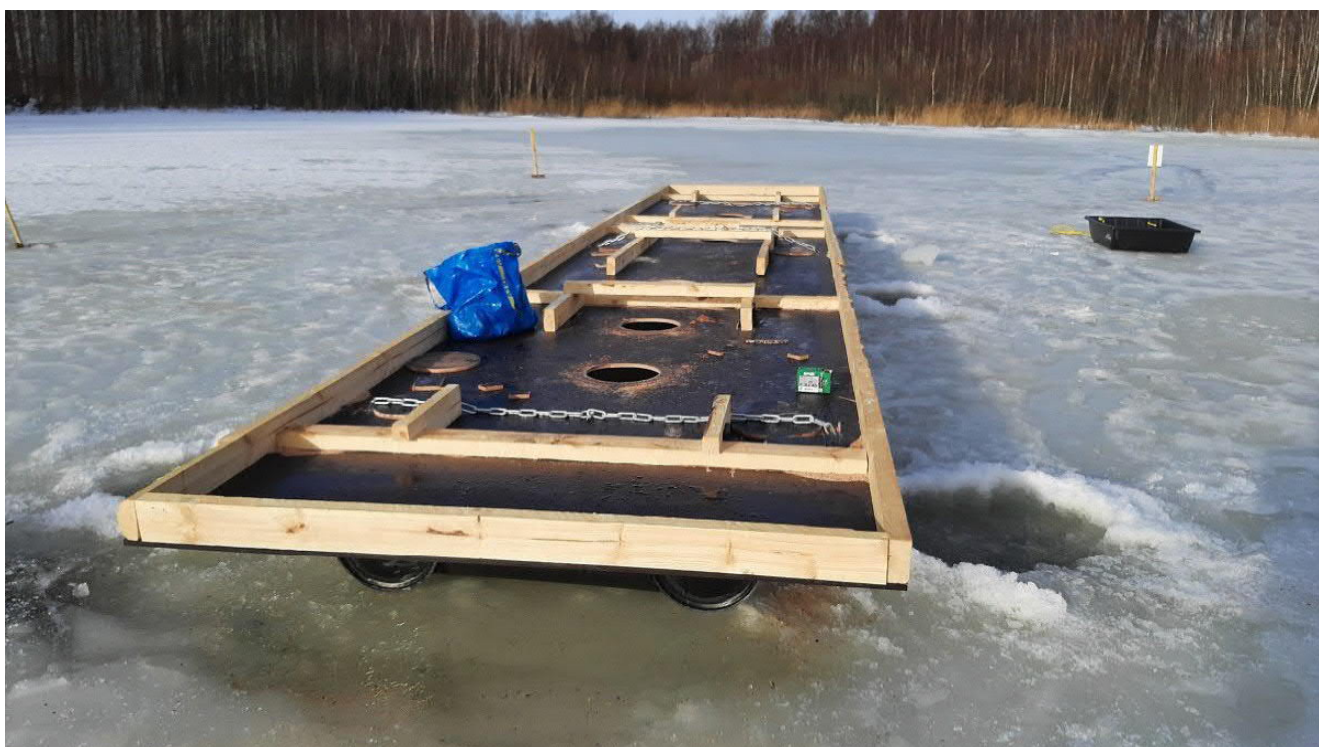
Kuva 3. Vesivanerilevyihin kiinnitettiin jo aiemmin laskettujen ankkuripainojen ketjut ja levyjä kiertävä laudoitus asennettiin. Pohjaan sahattuihin reikiin asennettiin pohjasta avoimet ämpärit kastelun varmistamiseksi.
