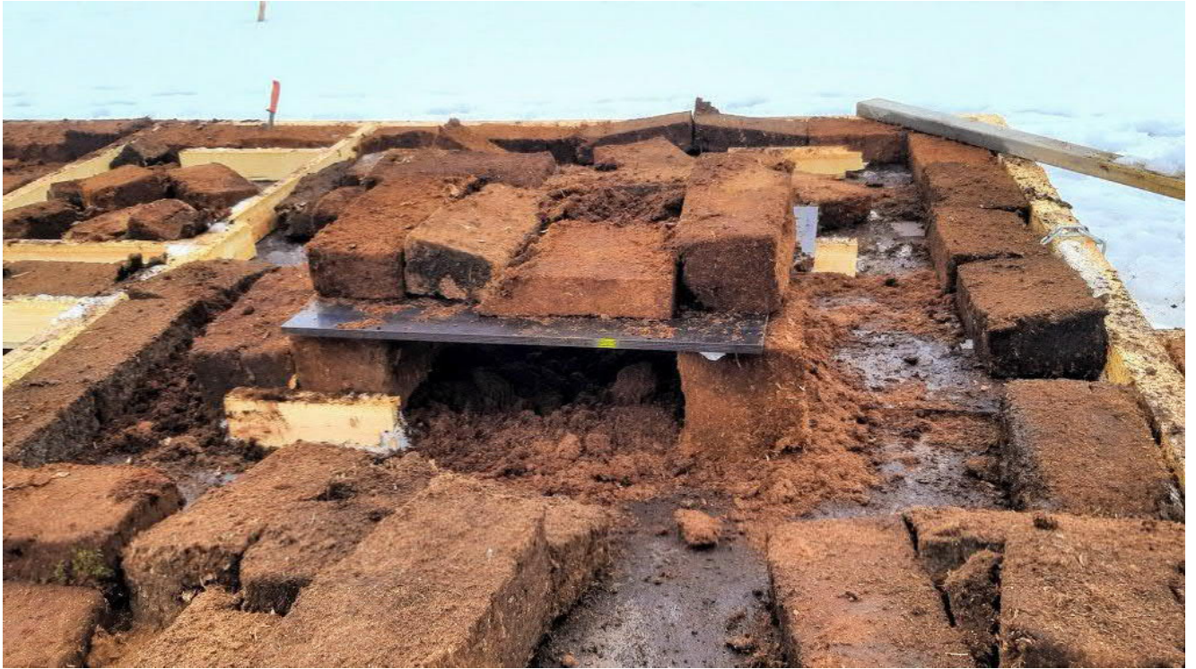
Kuva 4. Lauttojen pinnan päällystyksenä käytettiin turveharkkoja.
