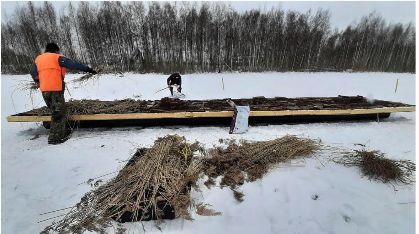
Kuva 5. Lauttojen pintaan lisättiin myös irtoturvetta ja rannoilta kerättyä järviruokoa ja muita talventörröttäjiä.
