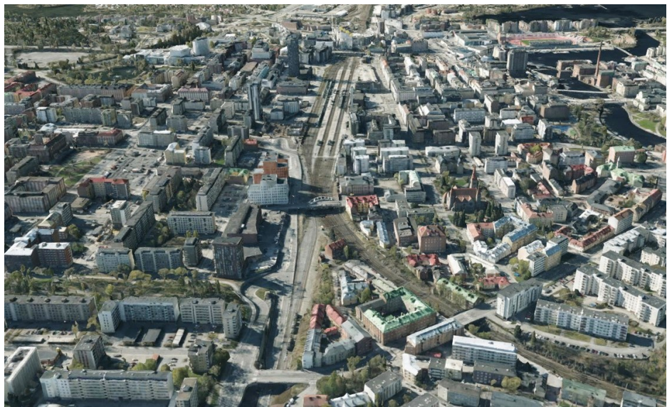
Tammelan, Tullin, Juhannuskylän ja Kyttälän kaupunkirakennetta. Kuvankaappaus 3D-kaupunkimallista. Katselusuunta pohjoisesta ratapihan suuntaisesti yli kohti etelää. (Lähde: Tampereen 3D-kaupunkimalli 2022)
