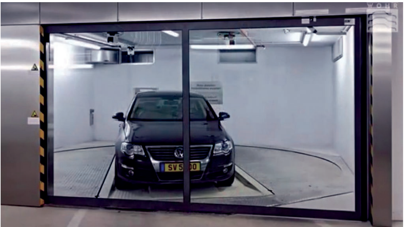
Kuva L1.1. Robottiparkin vaihtoalue (kuva: www.wöhr.de )
