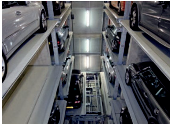
Kuva L1.2. Näkymä robottiparkin sisältä (kuva: www.wöhr.de )
