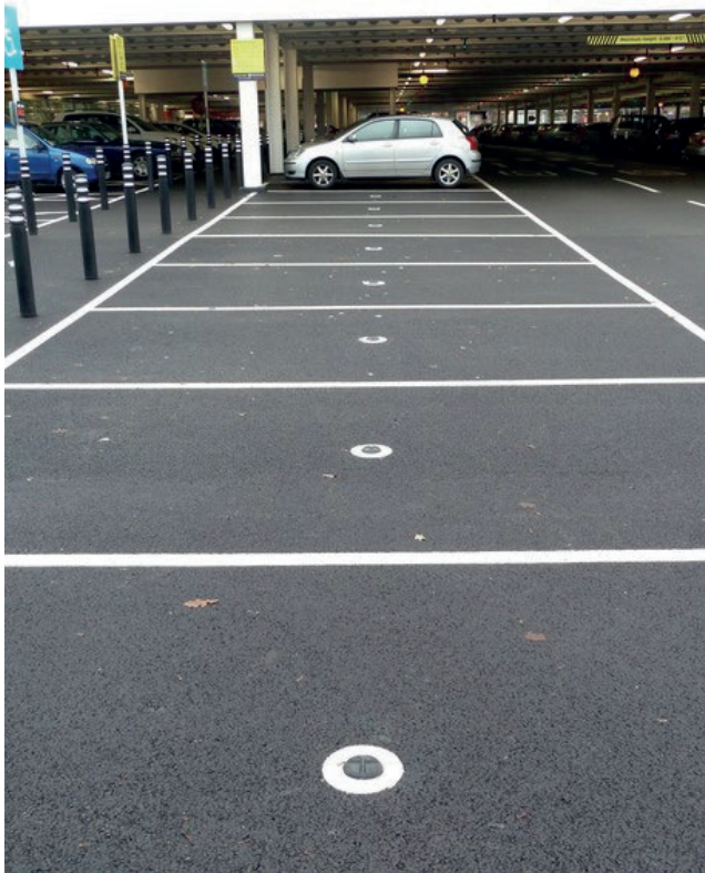
Kuva 14. Pysäköintiruutuihin asennettuja antureita. (kuva: http://www.nedapidentification.com/ )
