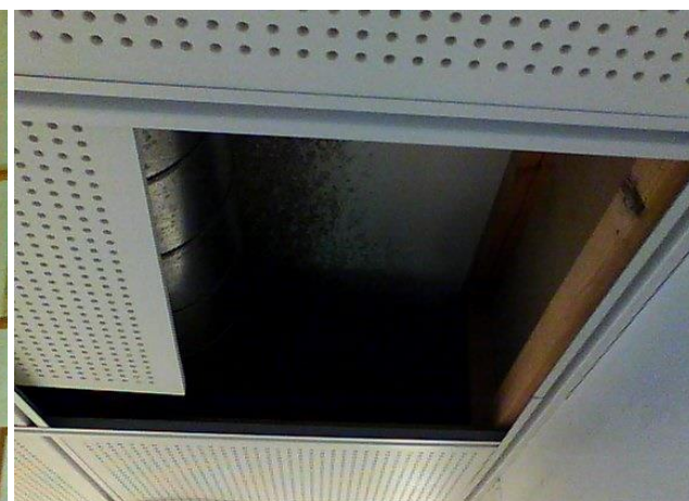
Kuvat 23 a ja b. Vasemmassa kuvassa esimerkki ryhmähuoneen sisäkatoista, jossa kattopintaan on liimattu akustolevyt. Oikeassa kuvassa käytävän alaslaskettua kattoa.
