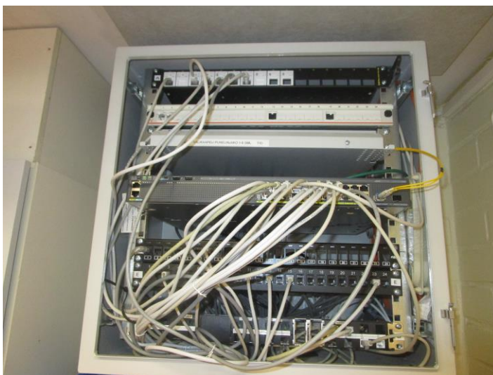
Kuva 10 Ristikytkentäteline
