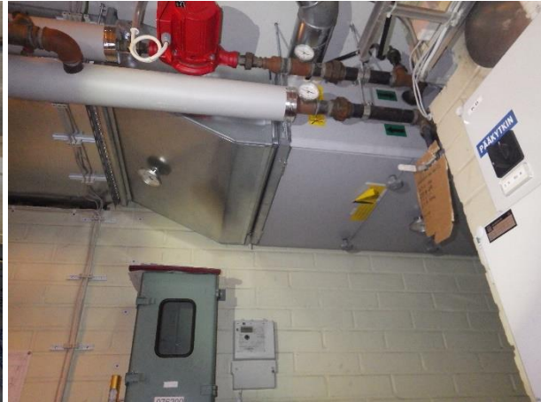
Kuva 25 a ja b. Päiväkodin tuloilmakone TK05 (a). Keittiön tuloilmakone TK06 (b).
