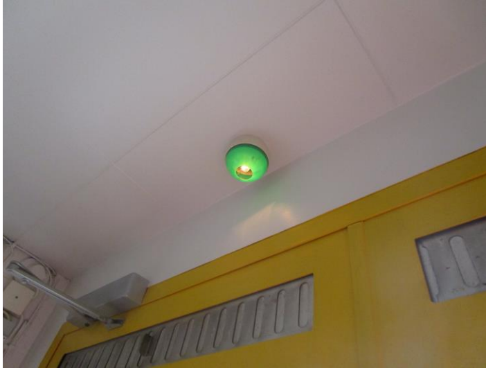
Kuva 9 Poistumistievalaisin
