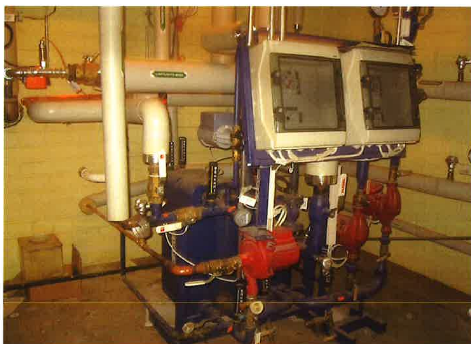
Kuva 8. Kiinteistön kaukolämpölaitteet.
