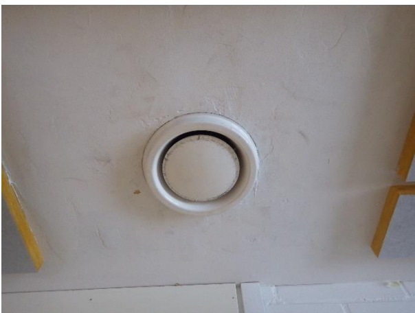
Kuva 29. Esimerkki poistoilmaventtiilistä.
