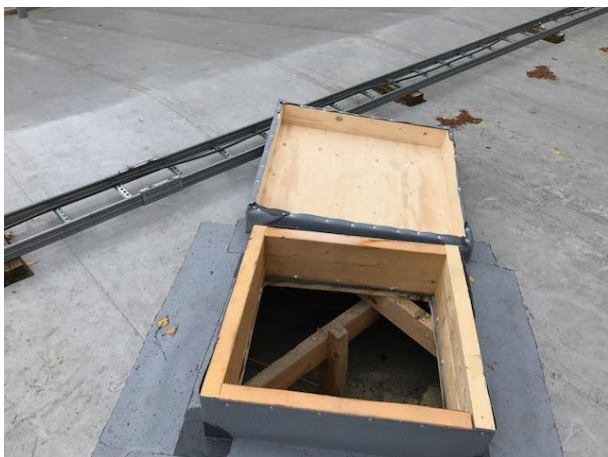
Kuva 22 a ja b. Vasemmassa kuvassa yleiskuva vesikaton rakenneavauksesta (YP avaus 4) ja oikeassa ko. avauksen kohdalta vesikaton aluslaudoitusta, jonka kuntoa voi pitää hyvänä.
