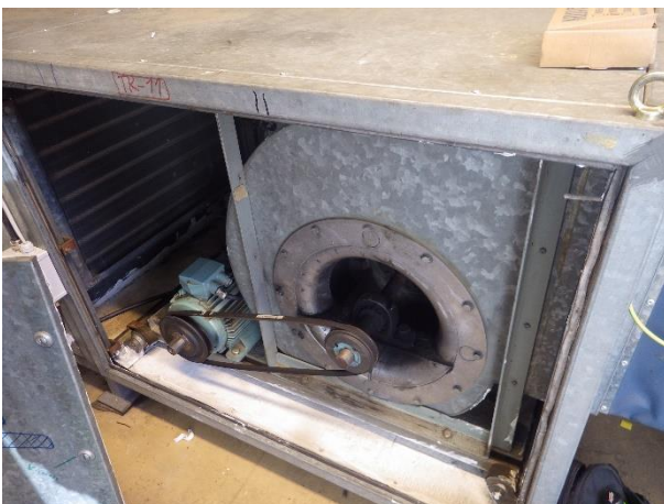
Kuva 26 a ja b. Päiväkodin tuloilmakoneen puhallinkammiossa on jälkikäteen pinnoitettua mineraalivillaa (a). Myös kanavaäänenvaimentimien mineraalivillaeristeet on pinnoitettu jälkikäteen (b).
