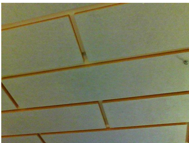
Kuvat 23 a ja b. Vasemmassa kuvassa esimerkki ryhmähuoneen sisäkatoista, jossa kattopintaan on liimattu akustolevyt. Oikeassa kuvassa käytävän alaslaskettua kattoa.
