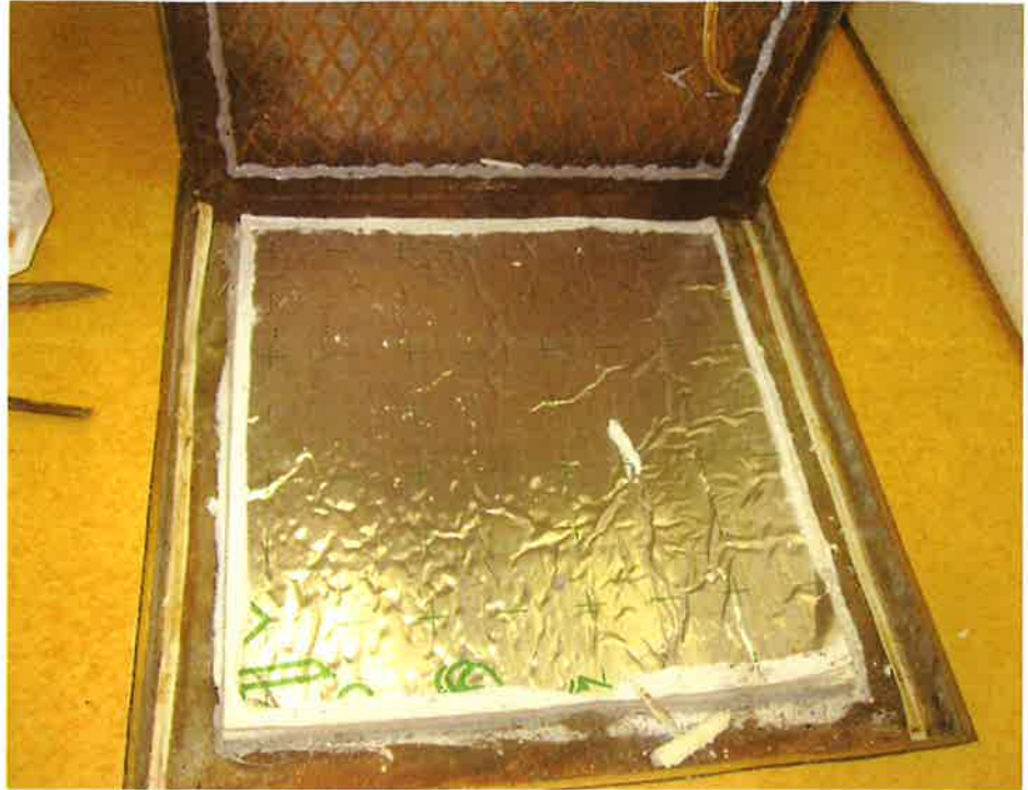
Kuva 10. Jätevesi- ja sadeveden tarkastusluukun liimattu kansi.
