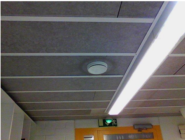
Kuva 24. Kuva eteistilan alaslasketusta akustolevykatosta.
