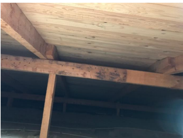
Kuvat 18 a ja b. Vasemmalla yleiskuva yläpohjatilasta harjalta räystäälle päin. Oikeassa kuvassa näkyvässä tuuletusrako räystäällä. Puurakenteet ovat pääsääntöisesti hyväkuntoisia.
