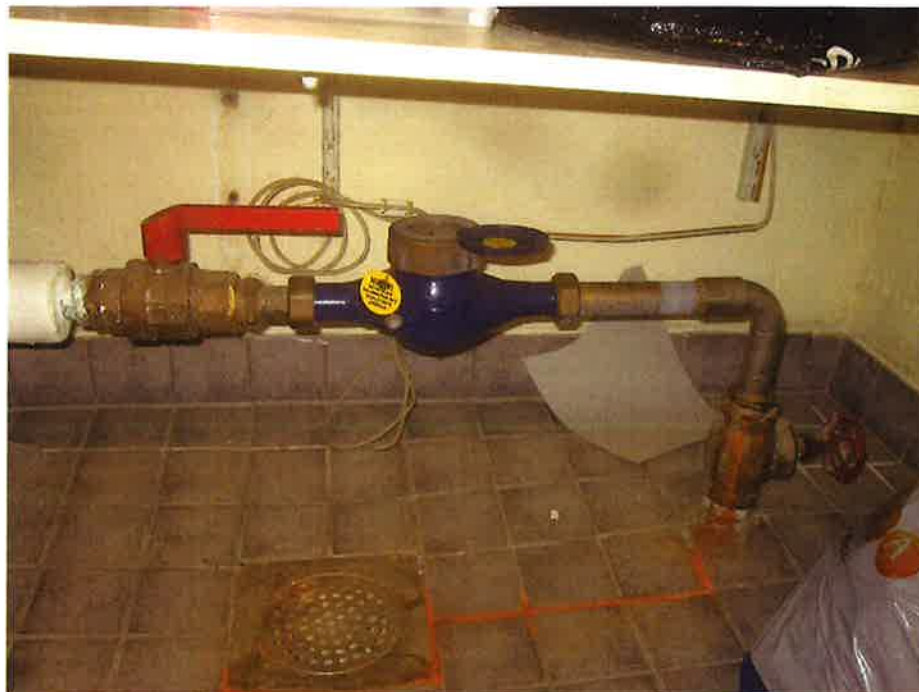
Kuva 1. Kiinteistön vesimittari.
