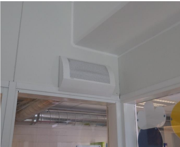
Kuva 33 a ja b. Erillistilan tuloilmapäätelaitteita.
