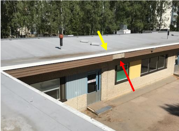
Kuva 16. Kuvassa näkyvässä räystäällä betoninen "vahvike" (punainen nuoli) samassa linjassa katteen avauskohdan kanssa (keltainen nuoli).
