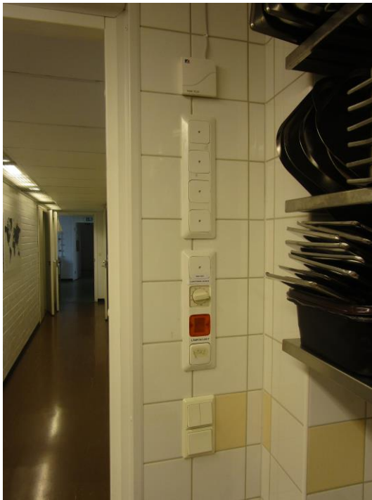
Kuva 5 Lämpölaitteiden käyttökytkin
