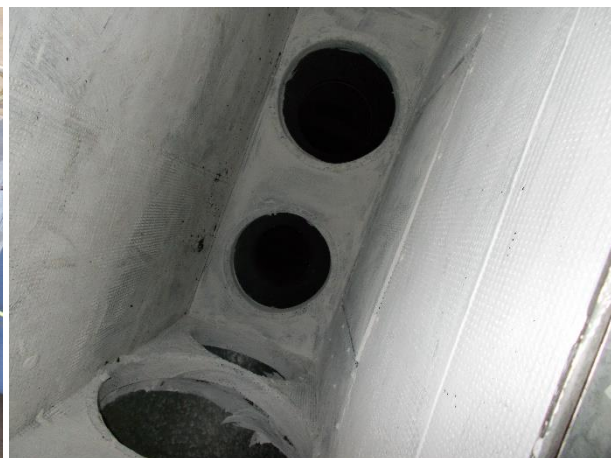
Kuva 26 a ja b. Päiväkodin tuloilmakoneen puhallinkammiossa on jälkikäteen pinnoitettua mineraalivillaa (a). Myös kanavaäänenvaimentimien mineraalivillaeristeet on pinnoitettu jälkikäteen (b).
