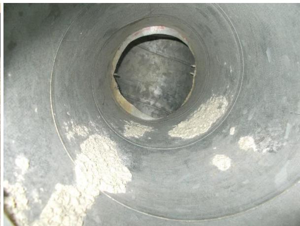
Kuva 28 a ja b. Ilmanvaihtokanavat kulkevat kylmässä ja korkeudeltaan matalassa yläpohjatilassa (a). Tuloilmakanavissa havaittiin rappausjämiä (b).
