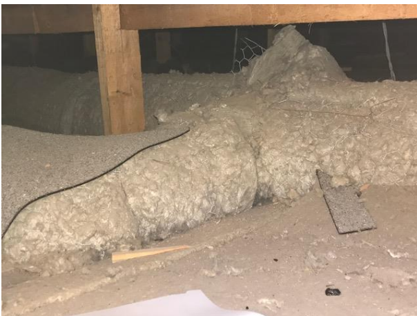
Kuva 28 a ja b. Ilmanvaihtokanavat kulkevat kylmässä ja korkeudeltaan matalassa yläpohjatilassa (a). Tuloilmakanavissa havaittiin rappausjämiä (b).
