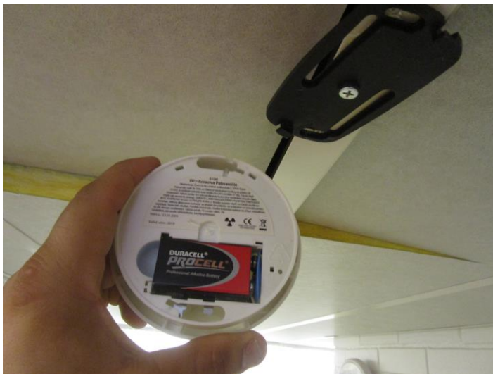
Kuva 13 Palovaroitin patteritoiminen
