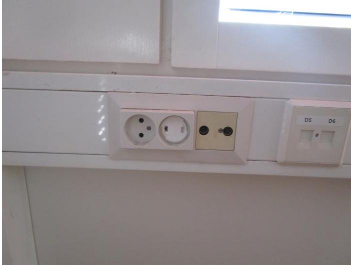
Kuva 7 Kourupistorasia
