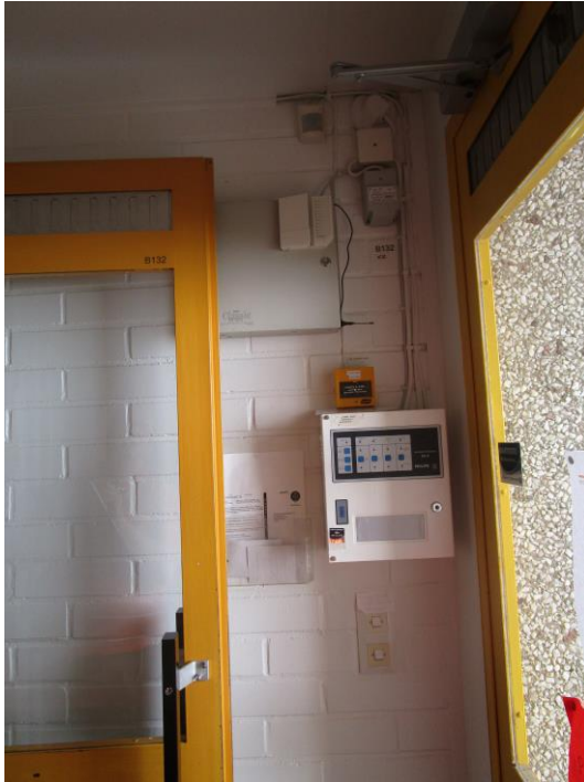
Kuva 12 Murtoilmoitinkeskukset
