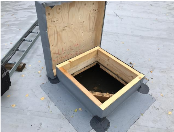
Kuvat 17 a ja b. Vasemmalla kuvassa (a) yleiskuva harjalle tehdystä kattoluukusta (YP avaus 3) ja oikealla yleiskuva vesikaton tuuletustilasta.
