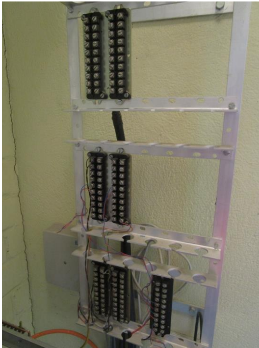
Kuva 11 Puhelinteline
