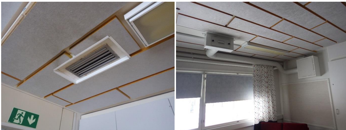
Kuvat 30 a ja b. Esimerkkejä tuloilmapäätelaitteista. Tuloilmapäätelaitteisiin on tehty lähivuosina muutoksia (b).
