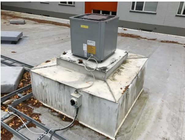
Kuva 27 a ja b. Esimerkkejä rakennuksen huippuimureista.
