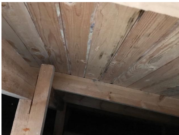
Kuva 22 a ja b. Vasemmassa kuvassa yleiskuva vesikaton rakenneavauksesta (YP avaus 4) ja oikeassa ko. avauksen kohdalta vesikaton aluslaudoitusta, jonka kuntoa voi pitää hyvänä.
