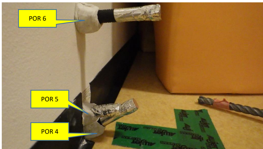
Kuva 7. Havaintokuva porareikämittauksista, jotka tehtiin 3 cm syvyydeltä ja kolmelta eri korkeudelta. Alin mittaussyvyys on vinosti lattian rajasta alaspäin poraus, keskimmäinen lattiapinnan tasossa ja ylin mittareikä noin 15 cm lattiapinnan yläpuolelta. Kuva kantavan väliseinän alaosiin tehdyistä porareikämittauksista.
