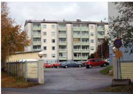
Multisillankdun luoteispuolella sijaitsevia kerrostaloja.
