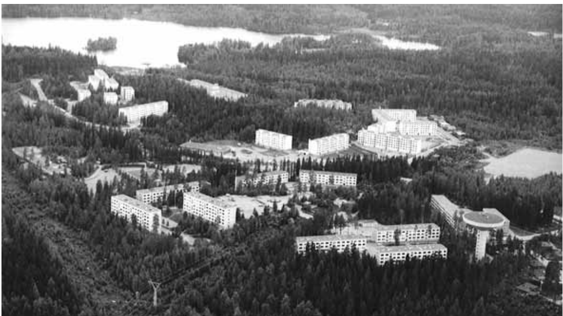
Ylemmässä kuvassa Multisilta lännestä nähtynä. Alhaalla vesitornin läheinen alue koillisesta nähtynä. (lähde: Tampereen Teknillinen Yliopisto / Olli Jokinen)
