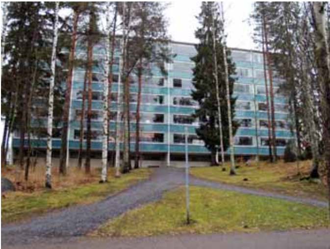
Uusittuja parvekkeita Lentävänniemenkadulla sijaitseissa taloissa.
