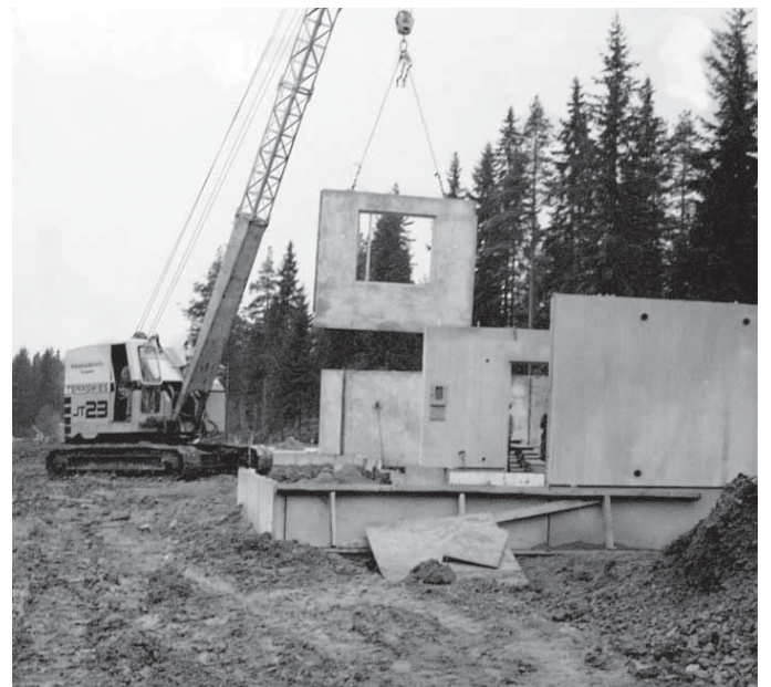
Ruotulan omakotitalot olivat maan ensimmäiset täyselementtirakenteiset pientalot. Parhaimmillaan yhden talon seinäelementit asennettiin viidessä tunnissa. (lähde: Aarre Mattisen valokuvakoelma / Rakennusliike Mattinen & Niemelä Oy)
