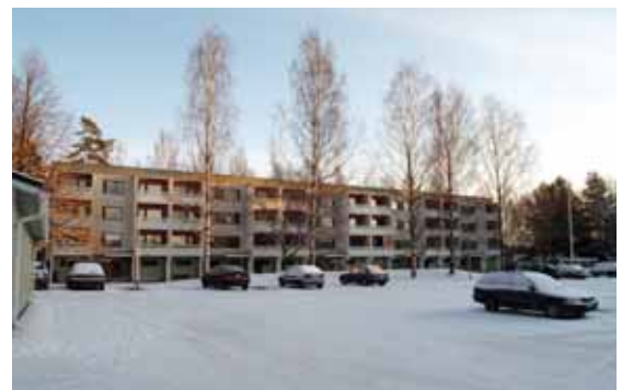
Annalassa on muutamia laajoja pysäköintialueita kerrostalojen välittömässä läheisyydessä.
