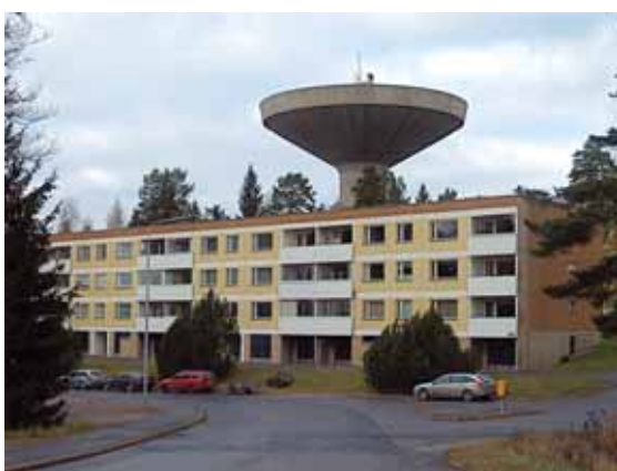
Peltolammin vesitorni erottuu selkeästi Multisillan Kitiniitynkadulle.
