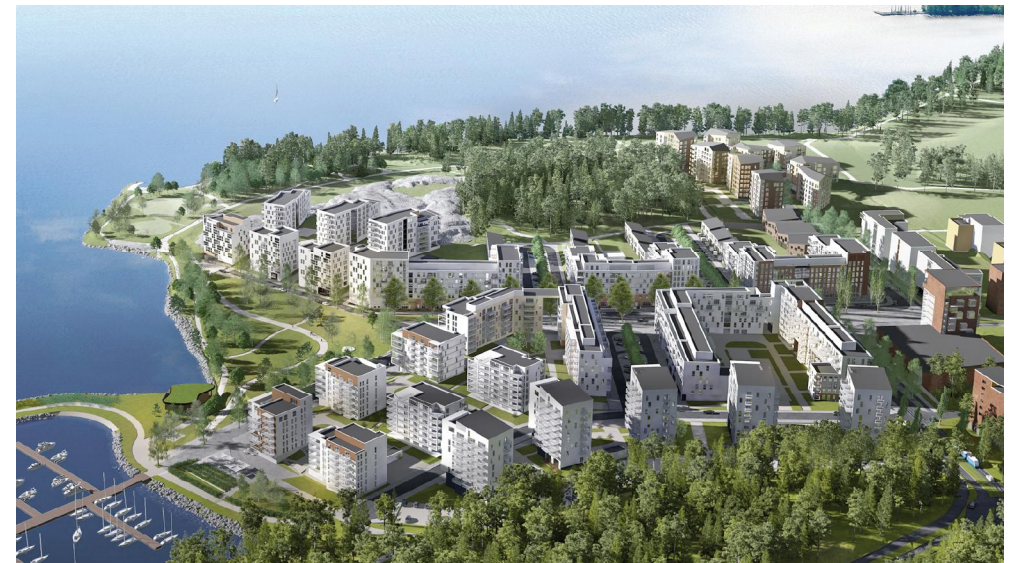
Korttelin 7921 tornit ( etualalla) muodostavat selkeän rajan pohjoiseen.
