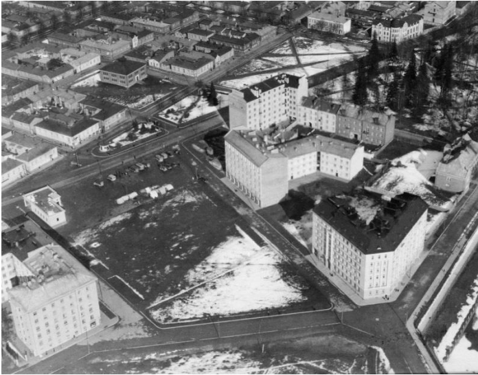
Kortteli puolivalmiina vuonna 1930. Pyynikintori 4 ja 8 puuttuvat. KUVA N. Rasmussen/Vapriikin kuva-arkisto
