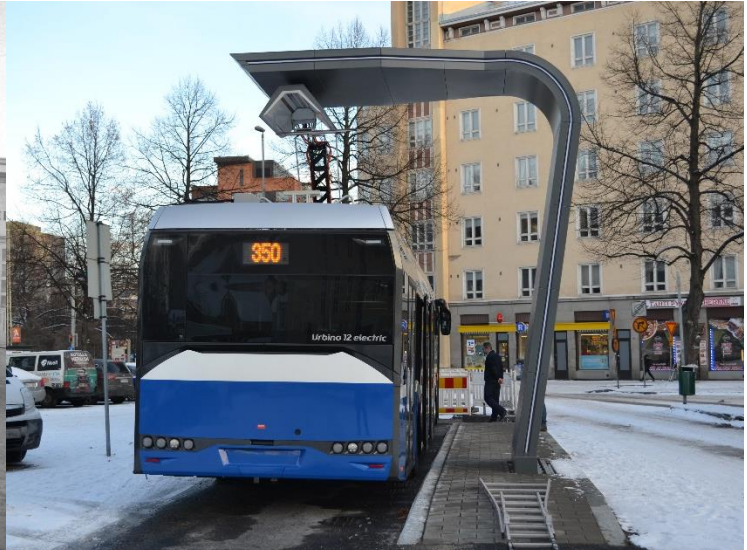
Sähköbussien latausasema koekäytössä marraskuussa 2016.
