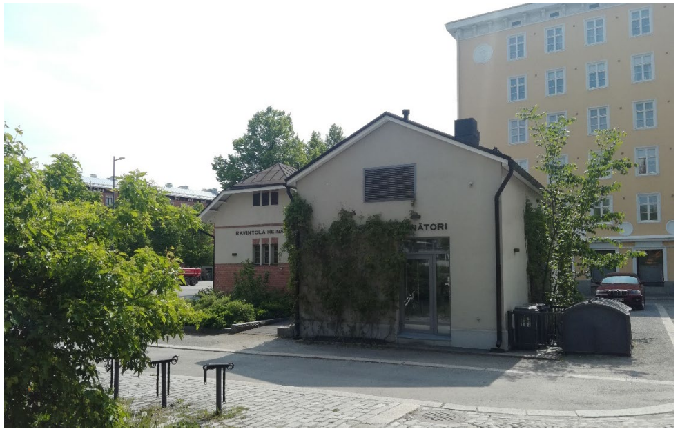
Kuva 12: Heinätorin vaakahuone ja Pirkankadun puolelle vuonna 2008 rakennettu lisäosa. Rakennuksessa on nykyään ravintola.
