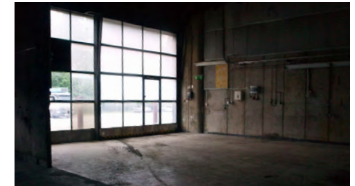
Alkuperäinen verstaatan lasiovi /-seinä
