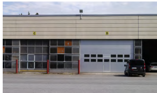
Länsijulkisivun alkuperäisiä ovia ja uusi nosto-ovi
