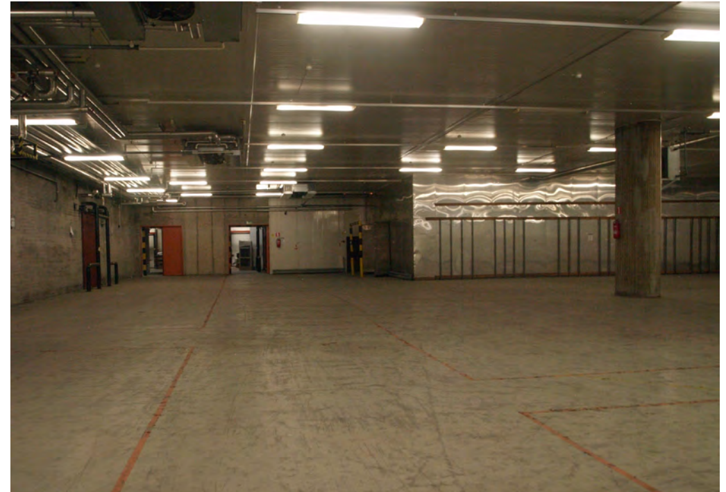
Lämmin varastotila, jossa on alunperin ollut kattoikkunoita.
