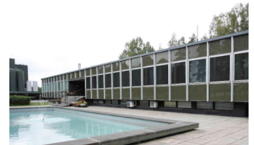
Valion Seinäjoen tehdas. Kuva: Valion Seinäjoen tehdas - Konttorin inventointi.
