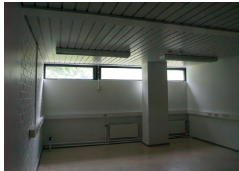
Koillissiiven tiloihin johtavat ovet
