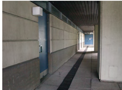
Koillissiiven tiloihin johtavat ovet
