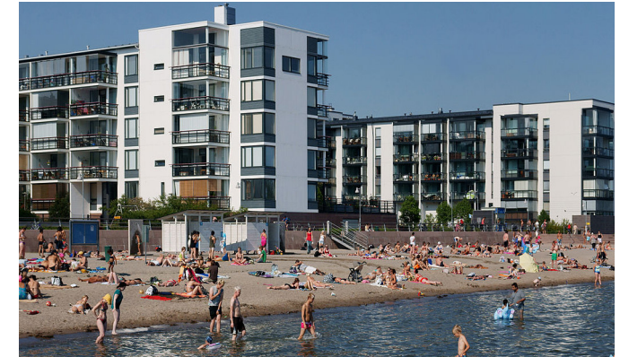
Helsingin Aurinkolahdessa Yksityiset pihat jäävät uimarannan taakse korotetun kevyen liikenteen väylän korostaessa tilallista eroa. Asuinrakennusten suuntautuneisuus ja kapeat päädyt rannalle päin eivät dominoi julkista rantaa liikaa. Kuva: Anna Levonmaa.
