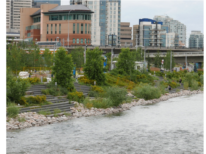
Monimuotoiset oleskeluportaat, jonne joki saa tarvittaessa tulvia ja jonne kasvillisuus tuo vihreyttä ja samalla rajaa yksityisempiä tiloja. Taustalla kohoaa Calgaryn keskusta ja vieressä uusi asuinalue East Village. Urban Riverwalk, Calgary. Kuva: Anna Levonmaa.
