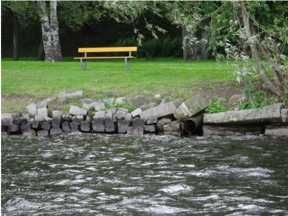
Kuva 1. Rannan kivipengerrystä tutkimusalueen keskivaiheilla.
