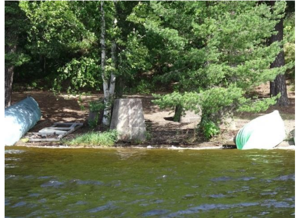
Kuva 2. Palomäen uimalan betoniperustuksia rannalla tutkimusalueen länsipäässä.
