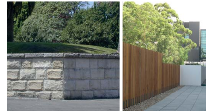
TUKIMUURIT KOROTTAMAAN DE GAMLAS HEMIN NURMIALUETTA UUDISTETTAVAN JALKAKÄYTÄVÄN REUNAAAN
