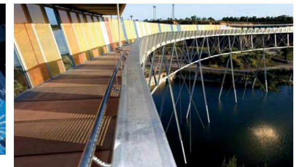
KEVYEN LIIKENTEEN SILTA - POPPY PLAZA (KANADA)
