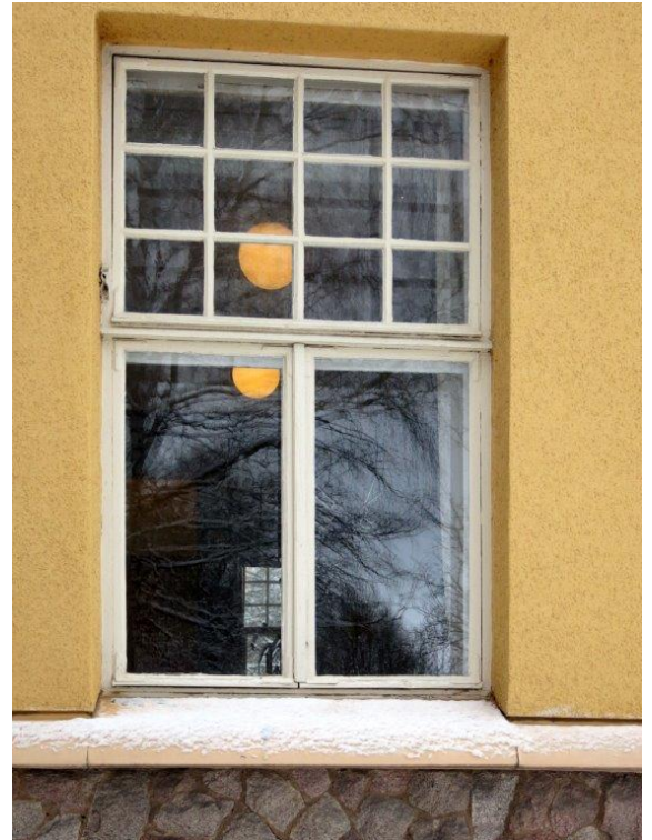
Keittiön ikkuna pohjoissivulla. Rakennuksen kaikki ikkunat ovat alkuperäisiä ja myös niiden heloitus on säilynyt pääosin.
