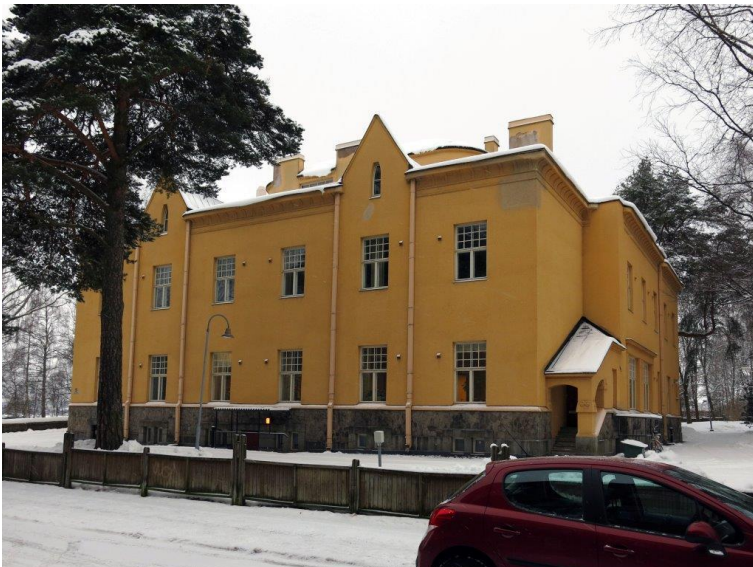
Itäsivu. Koristeaihe tai -kaide julkisivun yläosasta on jätetty toteuttamatta. Myös kukkalaatikot ovat kadonneet.
