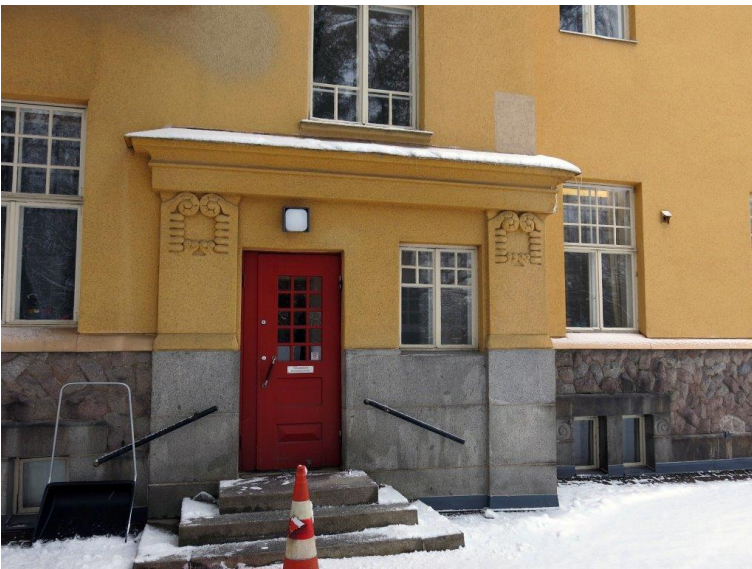
Sisäänkäynti länsisivun porrashuoneeseen (A). Pilasterien päiden koristeaiheet on toteutettu kasviaiheisina. Julkisivujen uudelleenrappaus on tehty koneellisesti. Rappaus on vedetty suurpiirteisesti myös koristeaiheiden päälle.
