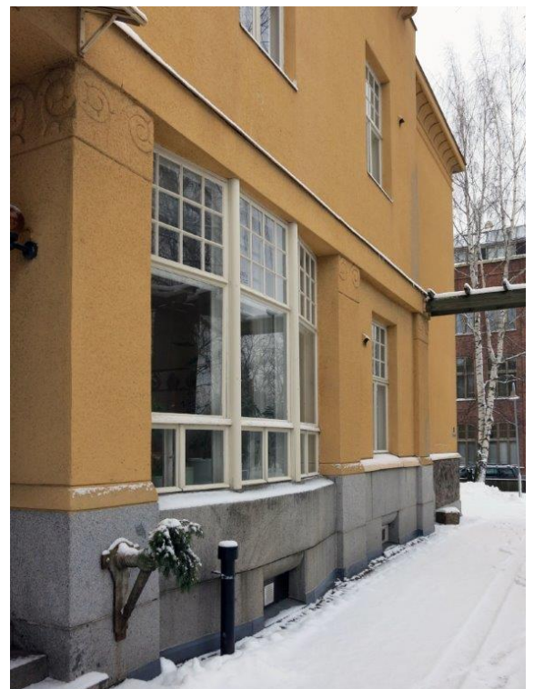
Oleskeluhallin eteläosan erkkerimäinen ikkuna.
