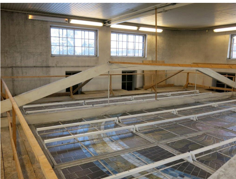
Ullakon keskiosan muodostaa kattolyhty, jonka vaakaikkunat antavat valoa halliin lattiassa olevan lasimaalauksen läpi. Ullakolle lasimaalauksen päälle on kiinnitetty huoltoa varten metalliset turvakaiteet ja valaistusta on tehostettu loisteputkilla.
