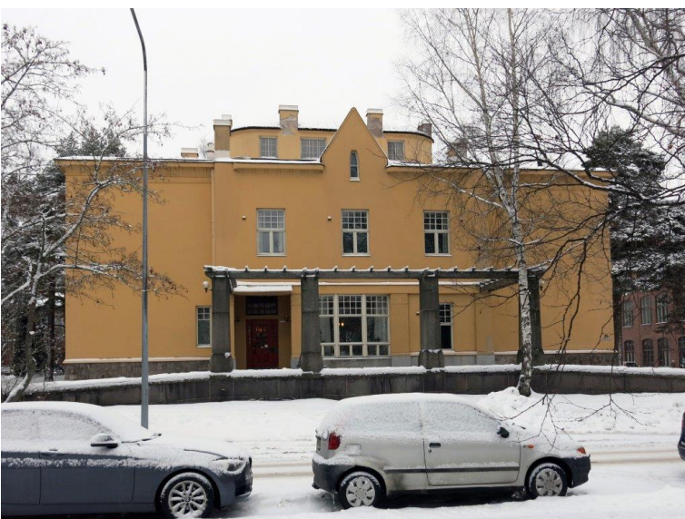
Eteläsiivu 2016. Julkisivut on kauttaaltaan rapattu uudelleen, kissa-aiheet ja kukkalaatikot ovat kadonneet.
