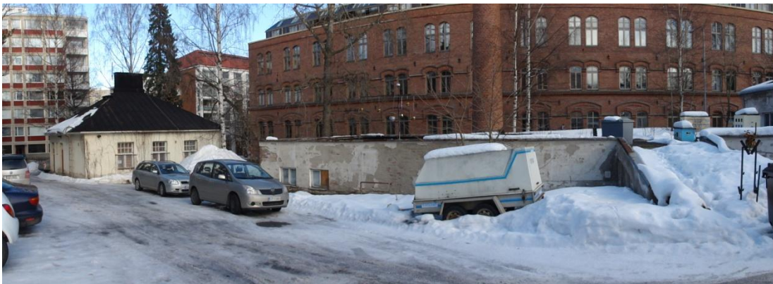
Kuva 5. Pyynikin entisen kulkutautisairaalan sauna (vasemmalla), lämpövoimala sekä voimalan piippu.
