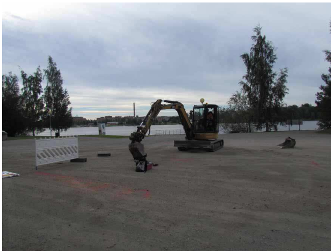
Kuva 29. Koeajan 3 sijaintipaikka hiekkakentän keskellä. Kuvattu pohjoisesta. (Kuva: Tampere, Frenckellin kalkkiriikin ja Nalkalan tiiliriikin koekaivaus 2015: 14)
