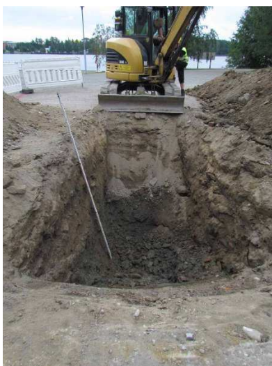
Kuva 30. Koeaja 3 kuvattuna pohjoisesta. (Kuva: Tampere, Frenckellin kalkkiriikin ja Nalkalan tiiliriikin koekaivaus 2015: 15)
