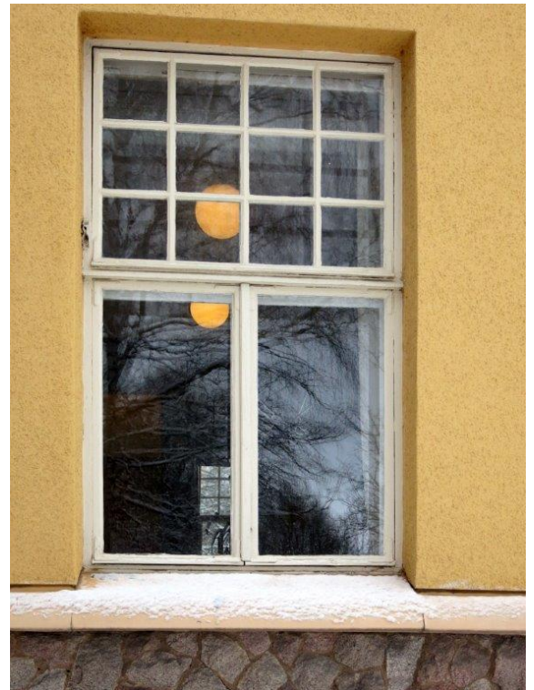
Keittiön ikkuna pohjoissivulla. Rakennuksen kaikki ikkunat ovat alkuperäisiä ja myös niiden heloitus on säilynyt pääosin.
