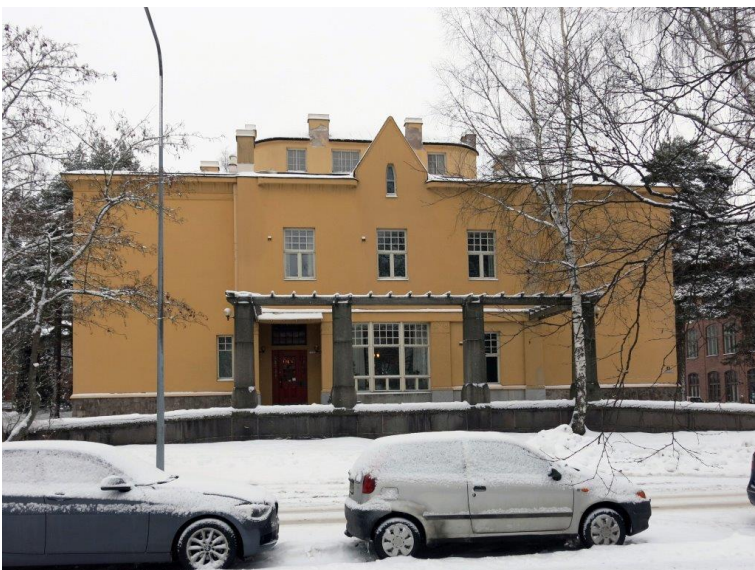
Eteläsivu 2016. Julkisivut on kauttaaltaan rapattu uudelleen, kissa-aiheet ja kukkalaatikot ovat kadonneet.
