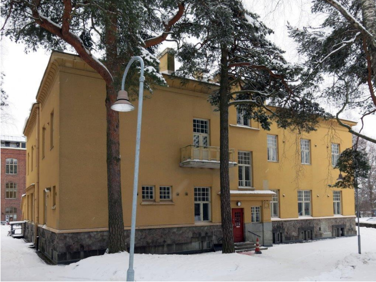
Länsisivu. Toiseen kerrokseen on rakennusvaiheessa tehty ikkunan tilalle ovi ja lisätty parveke.
