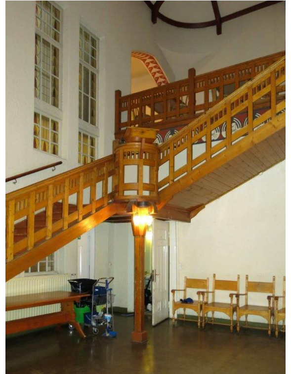
Hallista toiseen kerrokseen johtavat portaat (porras B), porrastasanteen puhujan paikka ja lyijylasi-ikkunat porrashuoneeseen (porras A).
