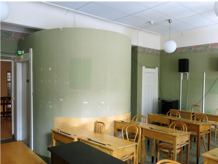
Kahdesta asuinhuoneesta yhdistämällä saatu suurempi luokkatila (204 ja 205) sekä hätäpoistumistieksi rakennettu kierreporras C.
