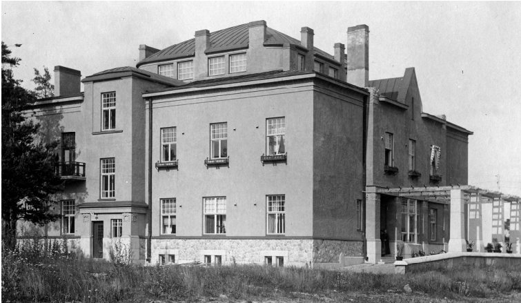
Lounaiskulma 1905-1910. Länsisivun ensimmäisen kerroksen toinen ikkuna oikealta on toteutettu suunniteltua kapeampana, porrashuoneen tornimaisen yläosan katto on loivempi ja rakennusvuosi on jätetty pois. Myös piippujen päät on toteutettu suoraviivaisempina.
