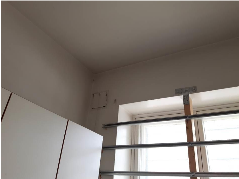
Kuva 30. Kärysaunan kattopinnoissa ei havaittu vaurioita.
