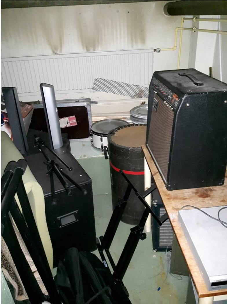
Kuva 41. Levypatteri ja termostaattinen patteriventtiili (90-luvulla uusittu)
