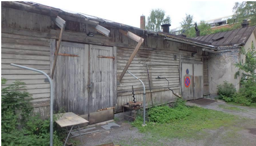
Kuva 14. Kylmän varaston puuverhouksen maalipinnat ovat kuluneet.
