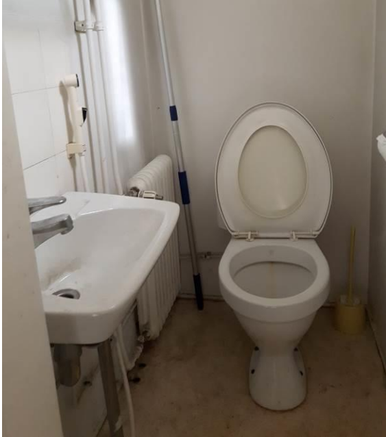
Kuva 38. Kärysaunan vesikalusteet (80-luvulta) ja lämpöpatteri (50-luvulta).
