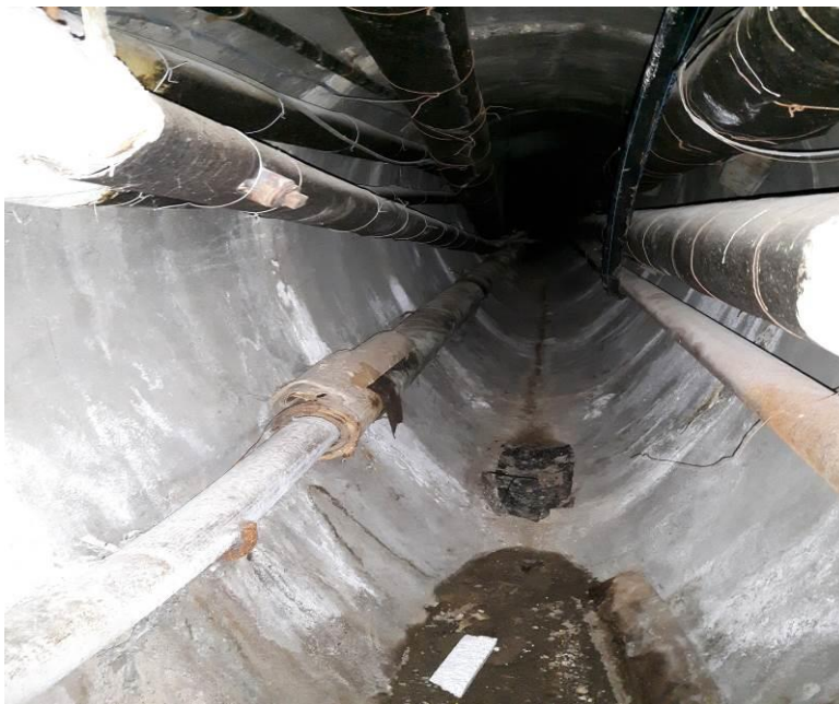
Kuva 37. Pihakanaali lämmönjakohuoneesta kuvattuna.
