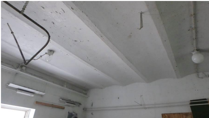
Kuva 8. Mehuaseman holvattu sisäkatto.
