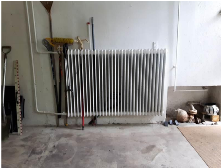
Kuva 40. Valurautainen patteri ja vanha patteriventtiili
