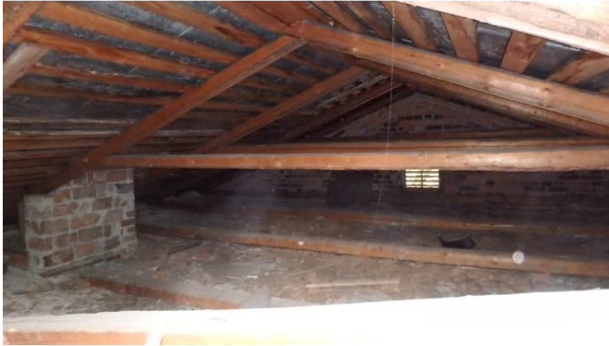
Kuva 9. Mehuaseman vesikaton alapuoliset rakenteet.
