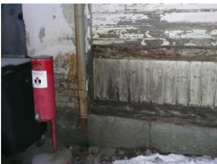
Kivi- ja puuosan liittymä pohjoisjulkisivussa
