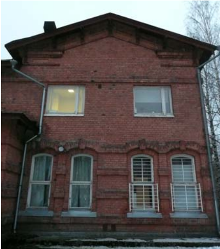
Kuva pohjoisjulkisivusta. 1. kerroksessa luultavasti alkuperäiset ikkunat, 2. kerroksessa 1950-luvun ikkunat.
