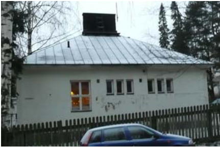
Pohjoisjulkisivussa on alkuperäisten piirustusten mukaan ollut kolme kolmen ikkunan riviä. Vasen ikkunarivi on 1950-luvulla korvattu 4-ruutuisella ikkunalla.
