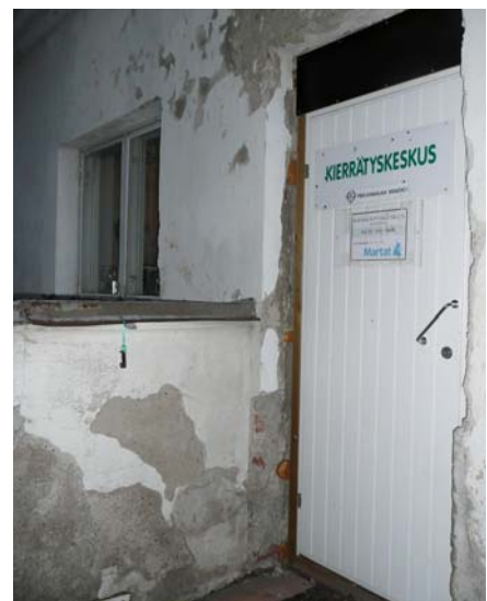
Uusittu puu-ulko-ovi kiviosassa johtaa Marttojen kierrätyskeskus-mehuasemalle.
