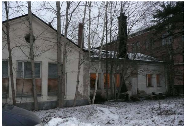
Kiviosan eteläjulkisivu. 1950-luvun modernisoinnissa vanhoja pariovia ja yläreunastaan kaarevia ikkunoita poistettiin. Kiviosan nykyiset ikkunat ovat pääosin 1950-luvulta.
