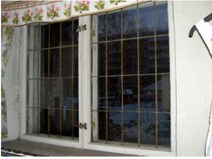
Kiviosan sisään-ulos-avautuva ikkuna 1950-luvulta
