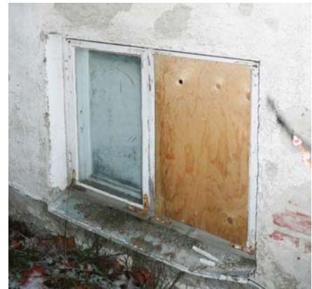
Kaikki rakennuksen ikkunat ovat 2-ruutuisia
