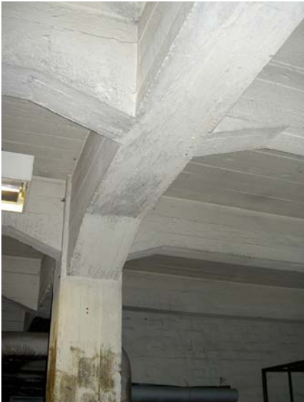
Rakennuksen lautamuottiin paikallavaletut betoniset kattopalkit ja pilarit
