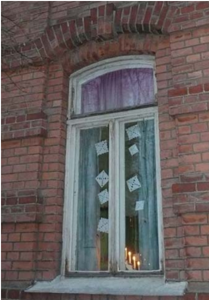
1. kerroksen alkuperäinen T-ikkuna
