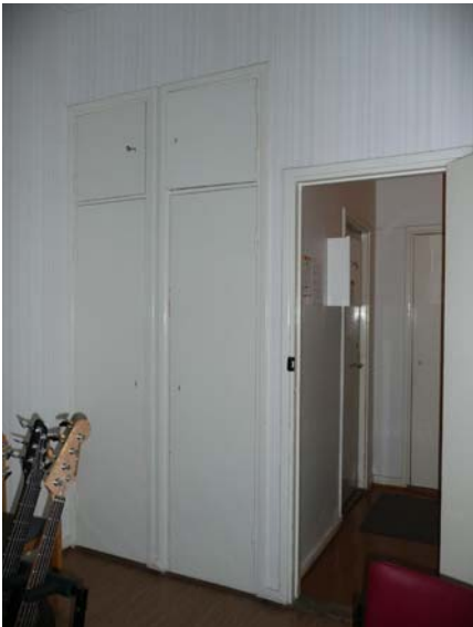
Yläkerran entisissä asuinhuoneissa on 1950-luvulla rakennetut pienet eteistilat, vaatehuoneet ja kiintokomerot.
