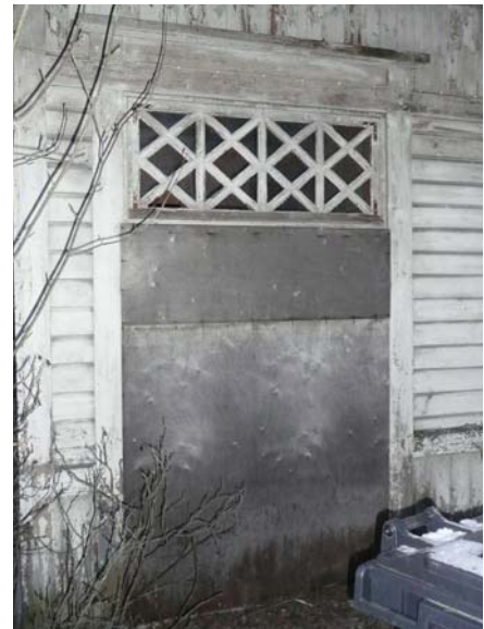
Puulevyn tilalla on alkujaan ollut puupariovet. Yläpuolinen vinoruutuikkuna on alkuperäinen.
