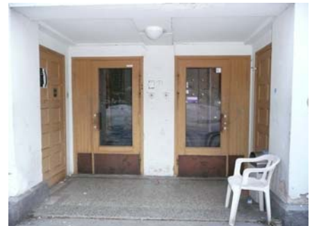
Rakennuksen pääsisäänkäynnin lasiaukolliset ulko-ovet ovat 1950-luvulta, kun taas niiden vieressä olevat peiliovet ovat luultavimmin alkuperäiset.
