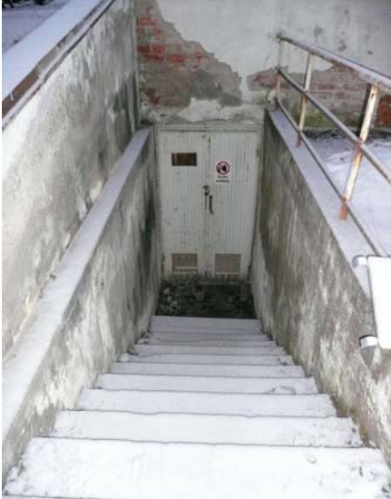
Puu-ulko-ovi entiseen muuntajahuoneeseen
