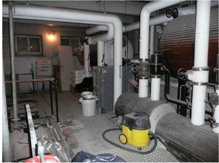
Rakennuksen pohjoisosassa sijaitseva entinen kattilahuone. Osa kattilahuoneen laitteista on purettu.
