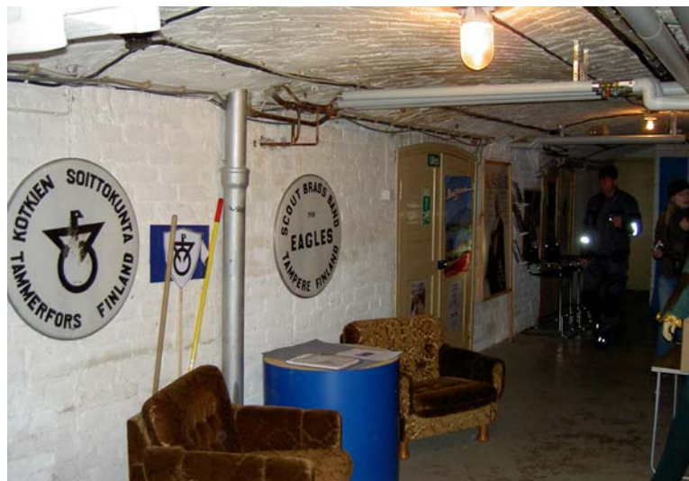
Kellarin holvattua keskikäytävää. Taustalla näkyy kaarevayläreunainen peilipariovi
