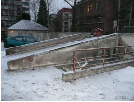
Rakennuksen katolle johtava ajoluiska
