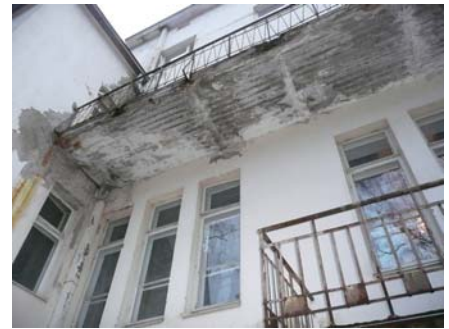
1. kerroksen jugend-tyylinen parvekekaide on alkuperäinen. 2. kerroksen parvekekaide on 1950-luvulta.
