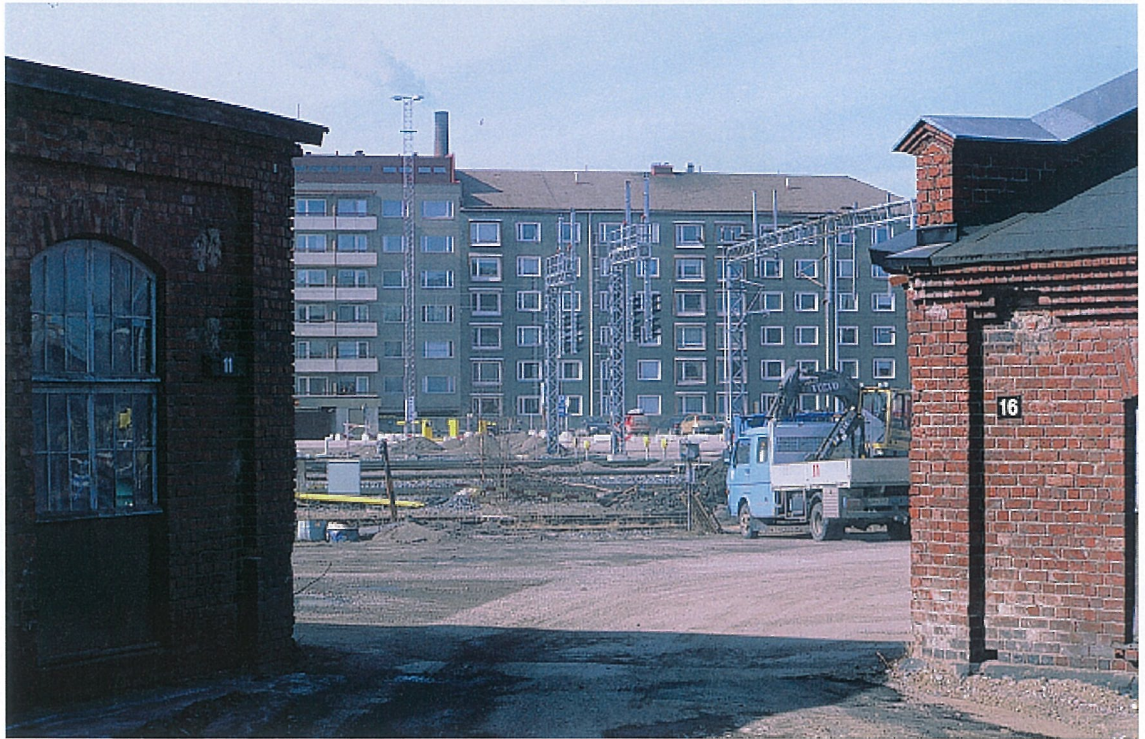
Kuva 7. Ratapihatilaa rajaavat rakennusmassat muodostavat kauempaa katsottuna kummallakin puolella ratapihaa maiseman. Tämä maisema avautuu Åkerlundinkadun päästä, toisen ja kolmannen veturitallin välistä. Porttimainen aihe tulee poistumaan, kun uusin talleista puretaan.
