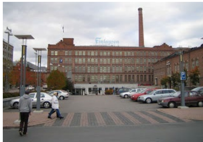
Näkymä pohjoiseen kohti Finlaysonin aluetta.
